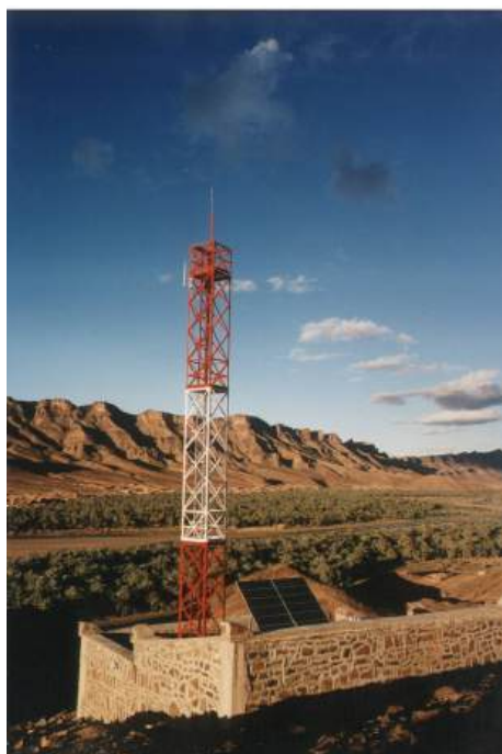
FIGURA 1.3: Sistema fotovoltaico autónomo alimentando un radioenlace.
