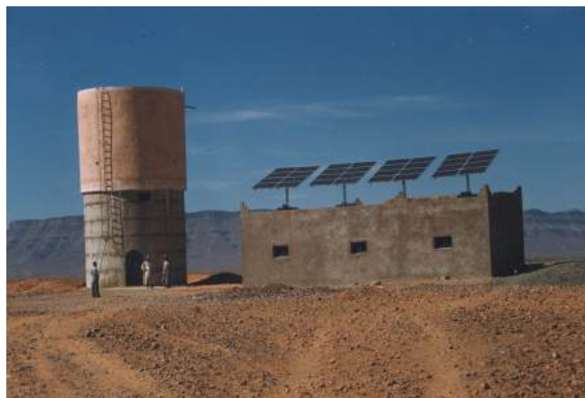
(B) Sistema de bombeo con depósito elevado.
