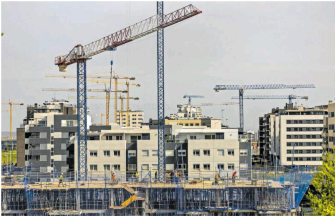
Viviendas en construcción en El Cañaveral, en Madrid, en marzo. SAMUEL SÁNCHEZ
