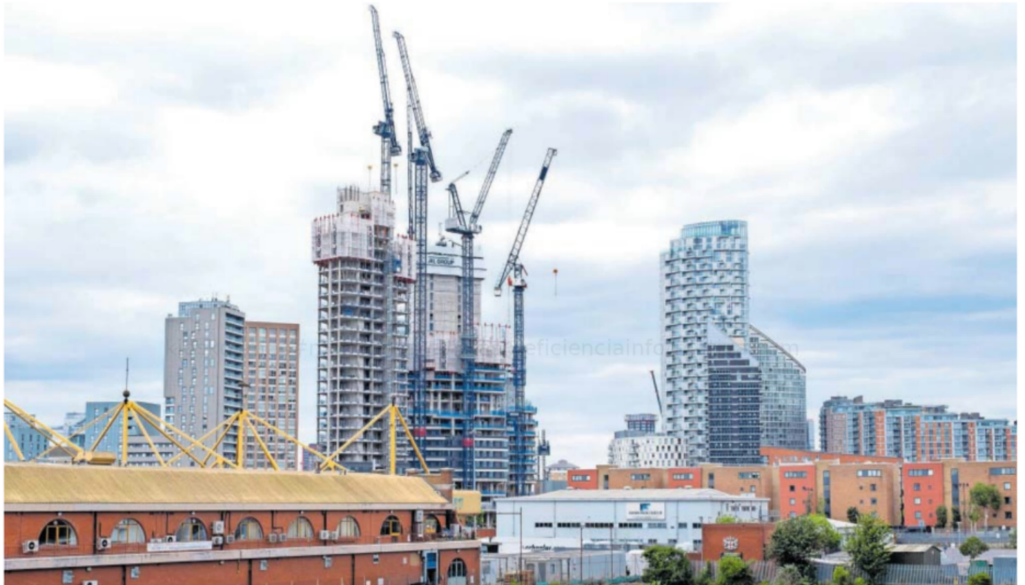
Viviendas en construcción en Poplar y Canning Town, cerca del distrito financiero de Canary Wharf, en Londres. MIKE KEMP (GETTY)
