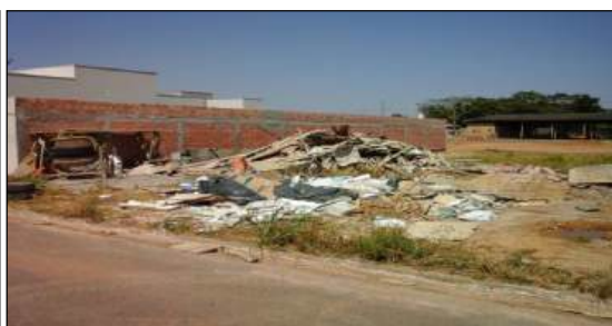
Figura 2 - Deposição irregular de resíduos de construção e demolição na cidade de Sinop/MT
