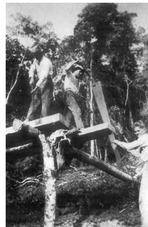
Serrando madeira na mata para construção de casa
