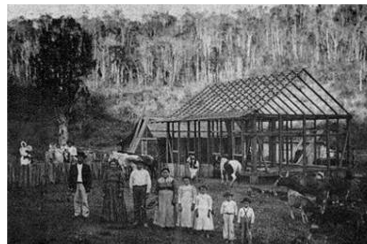
Enxaimel para receber tijolos crus ou queimados
