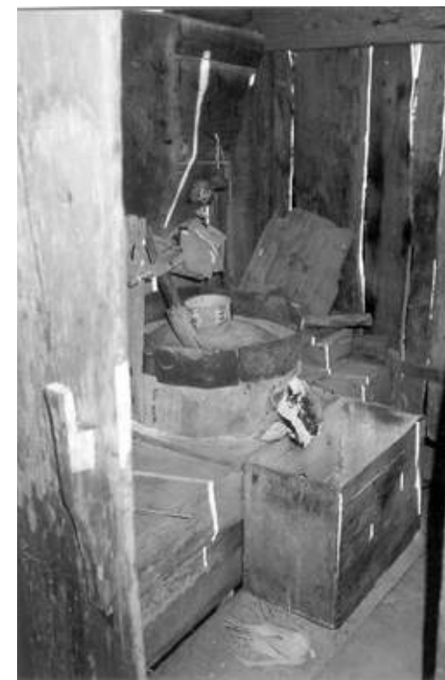
Interior do moinho para moagem de milho através do atrito de pedra com pedra
