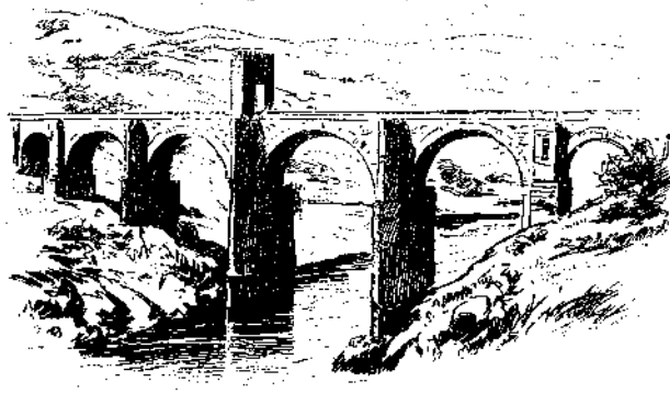
Fig. 42. — Puente romano de Alcántara.
