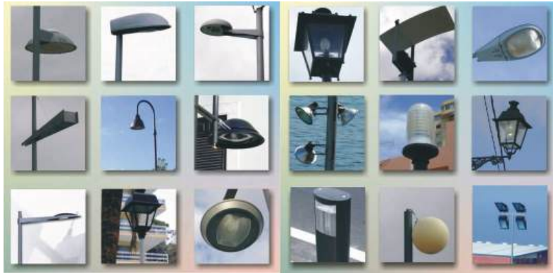
Figura 6: Ejemplos de luminarias adecuadas (izquierda) e inadecuadas (derecha) para combatir el problema de la contaminación lumínica. Cortesía de la Oficina Técnica para la Protección de la Calidad del Cielo (OTPC-IAC), http://www.iac.es/otpc/OTPC-IAC .
