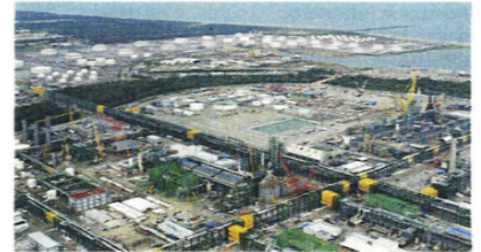
La refinería ubicada en Dos Bocas se encuentra en fase de arranque progresivo.
