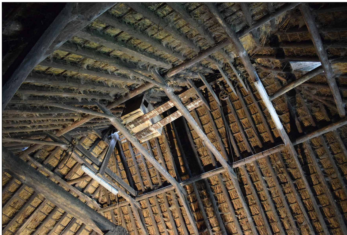
Afbeelding 59. De kap van de boerderij met vliergebinten.
