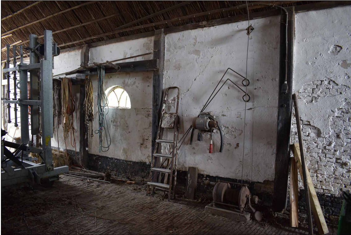
Afbeelding 19. De westgevel, gezien vanuit de rijng. De muur is gestuct en wit geverfd, met onderin een zwarte plint. Tegen de gevel staan houten stijlen. Zij zijn door middel van ankers verbonden met de muur.
