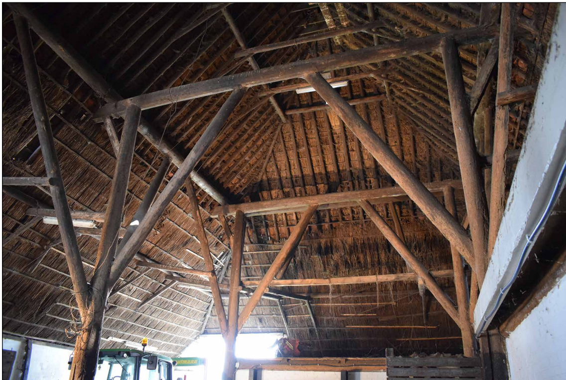
Afbeelding 42. Het vierkant gezien richting de voorgevel.
