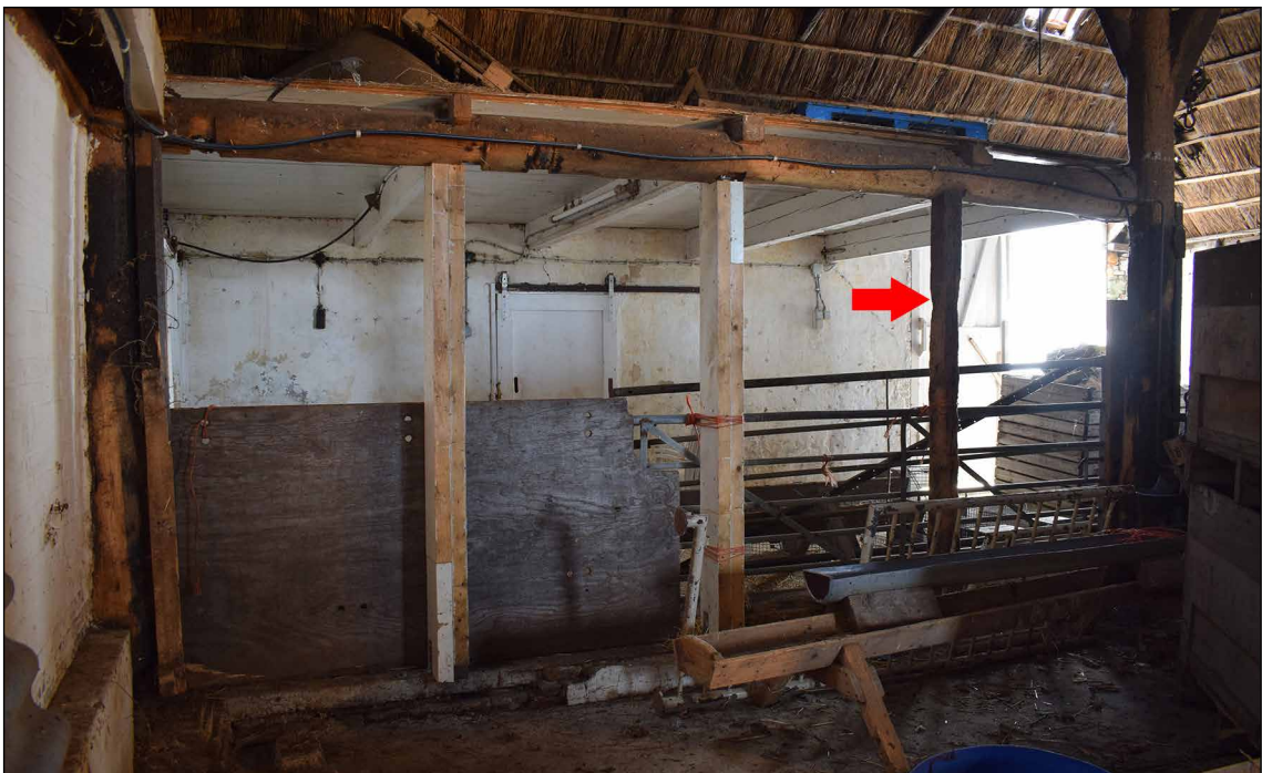
Afbeelding 18. Restanten van een houten wand tussen de hooiberg en de ruimte aan de achterkant van de boerderij. Alleen de rechterstijl is origineel (bij de pijl).
