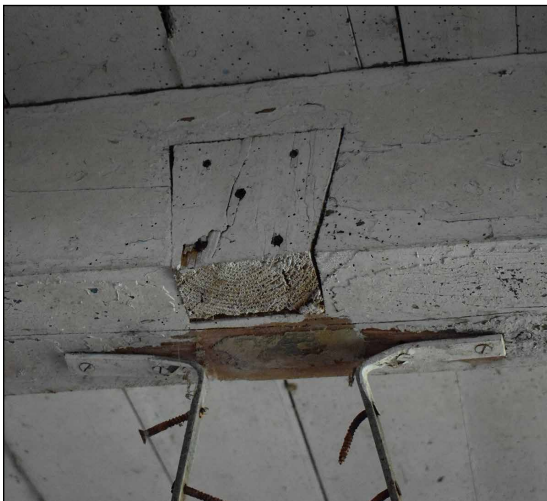
Afbeelding 35. Houtverbinding van een afgezaagde stijl.
