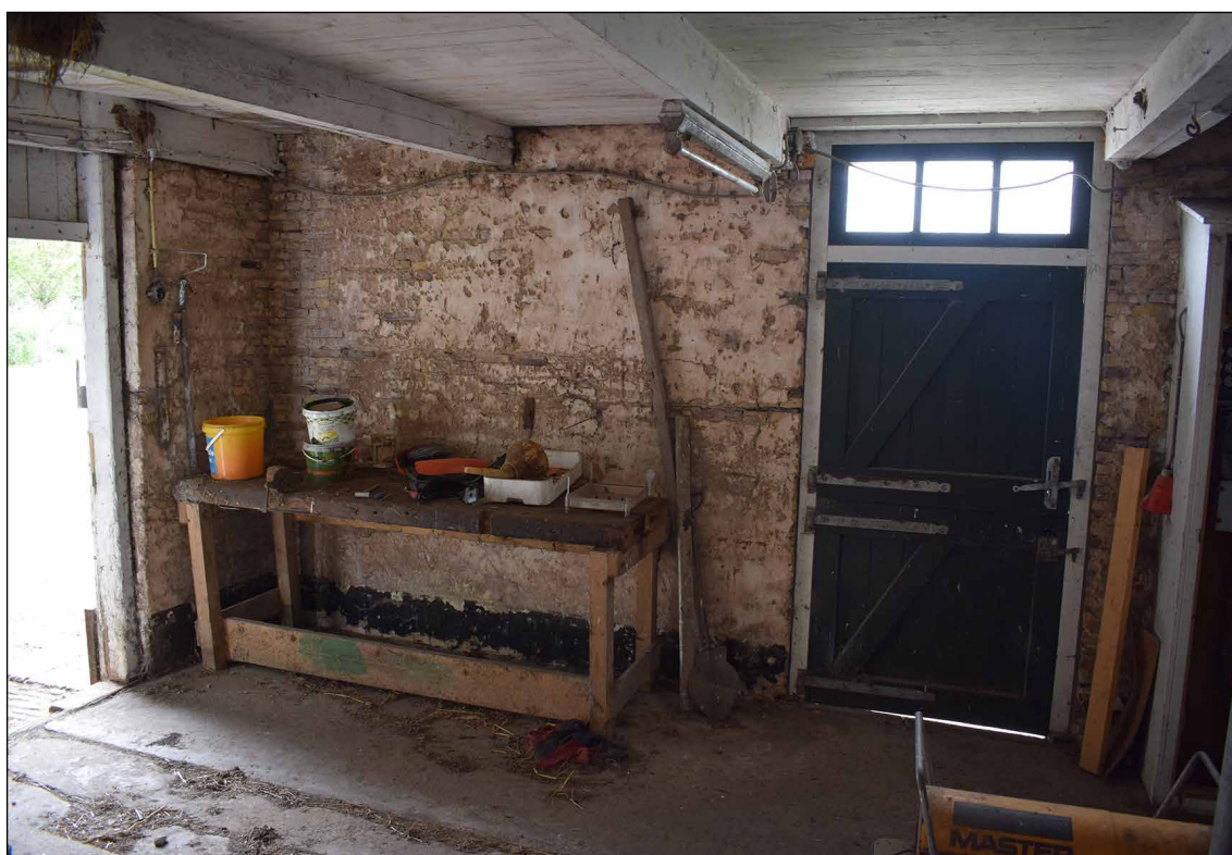
Afbeelding 25. De noordgevel, gezien vanuit de paardenstal. De zolderbalk geheel links is versterkt met een stuk hout tegen de zijkant van de balk aan.
