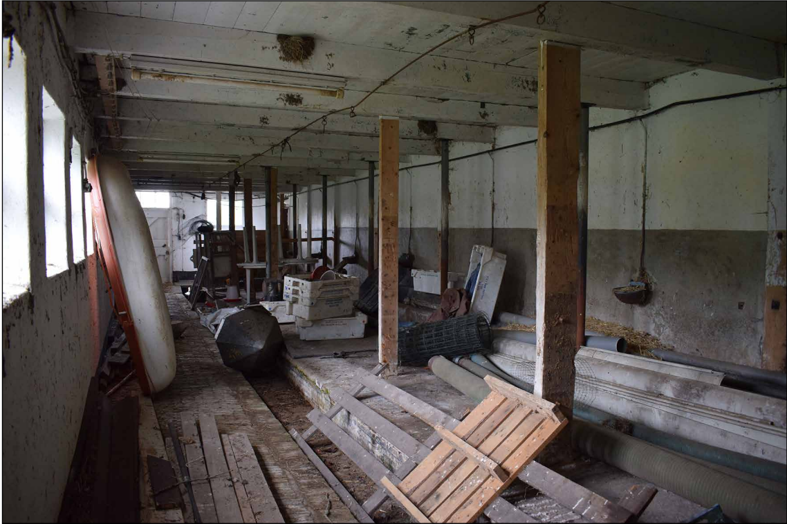
Afbeelding 29. De koeienstal, gezien richting het zuiden.
