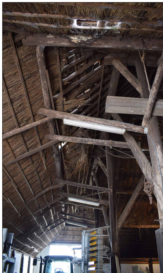
Afbeelding 58. Gording boven de rijng.
