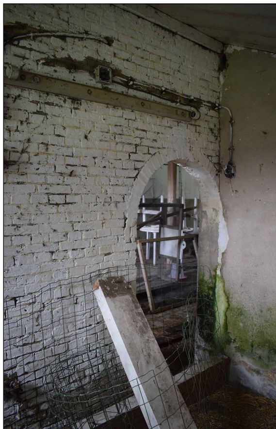
Afbeelding 16. De wit geverfde oostgevel, gezien vanuit een jongveestal. De boog van de deur was oorspronkelijk een halfronde stalraam.
