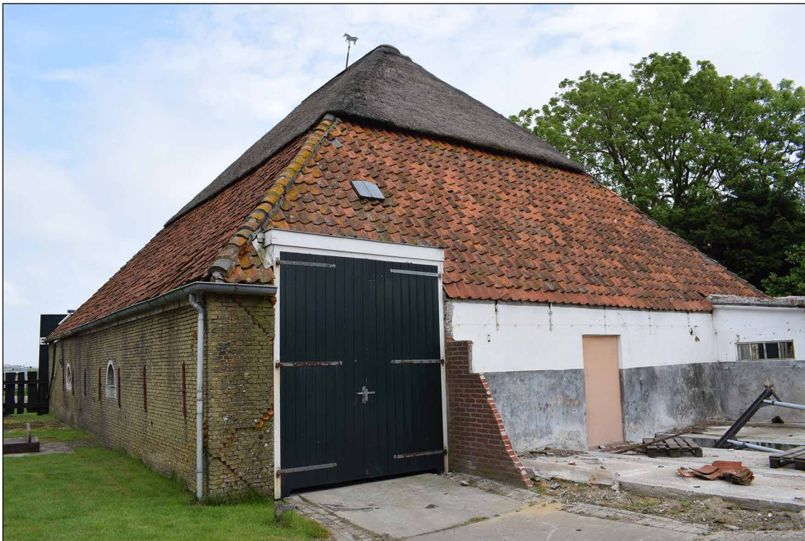
Afbeelding 12. De zuidgevel van de stolpboerderij. De darsdeur is pas in recente tijd verhoogd. Rechts de resten van de aangebouwde stal.
