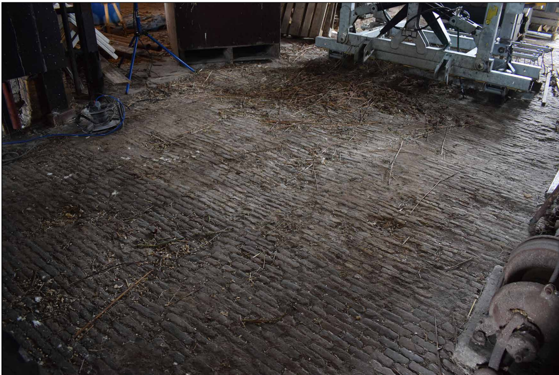
Afbeelding 20. Bestrating met gele bakstenen in de rijng.
