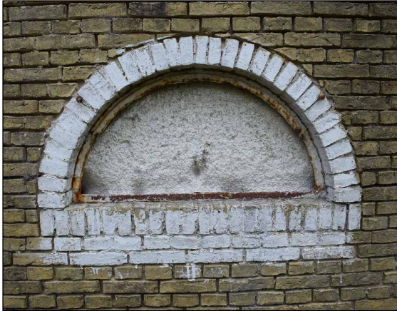
Afbeelding 10. Stalraam in de westgevel, dichtgezet met piepschuim.
