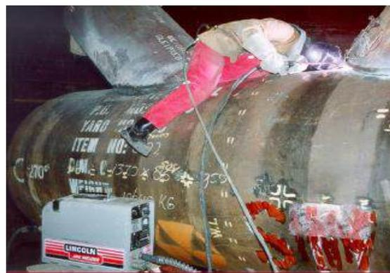
Figura 153. Aplicación del proceso G.M.A.W. en plataformas petroleras.
