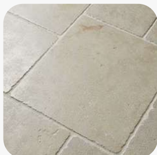
Плитка на полу
