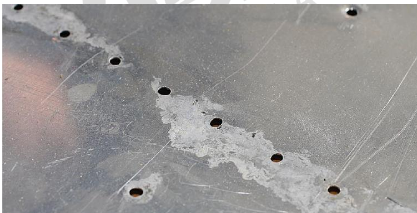
Fonte: FAA - Federal Aviation Administration - Mechanic Training Handbook Corrosão superficial
