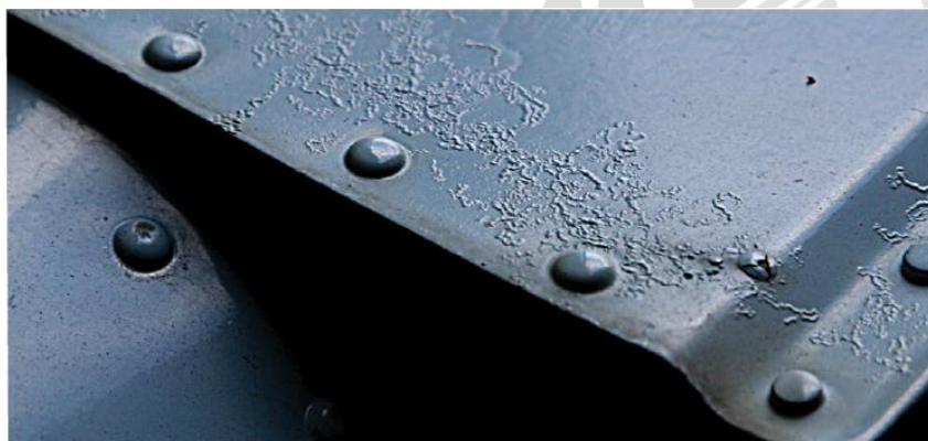
Fonte: FAA - Federal Aviation Administration - Mechanic Training Handbook Corrosão superficial em baixo da pintura
