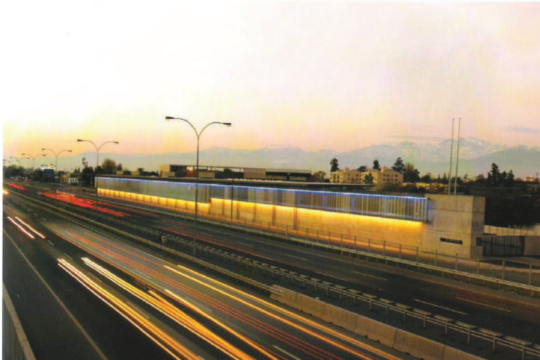
Imagen: Centro de atención emergencias sur. Fuente: Revista ARQ. N°60.
