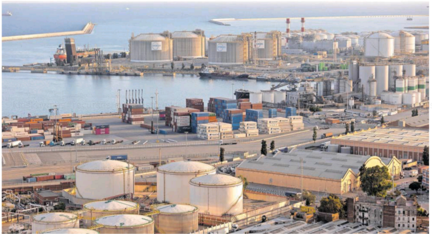
Tanques de almacenamiento de hidrocarburos de Exolum frente a una regasificadora de Enagás en el puerto de Barcelona. ALBERT GARCIA
