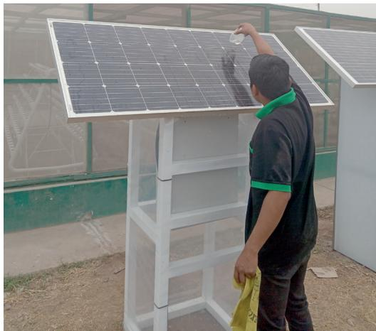
**Figura 32.** Limpieza del panel solar con agua
