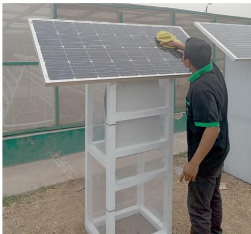
**Figura 33.** Limpieza del panel solar con franela
