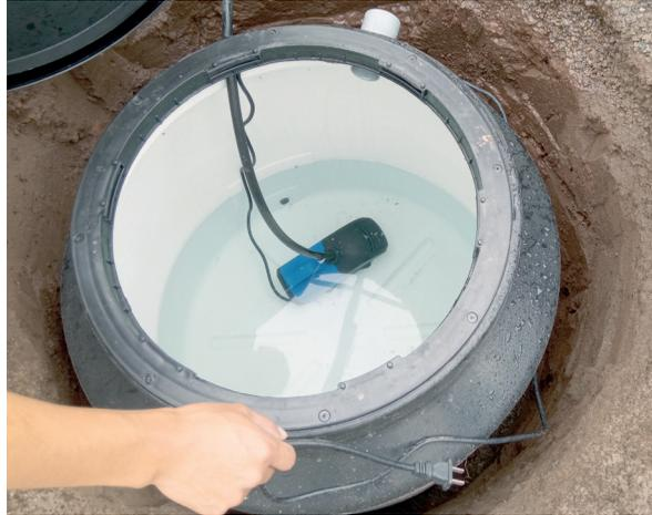
Figura 29. Revisión del nivel del agua respecto a la bomba
