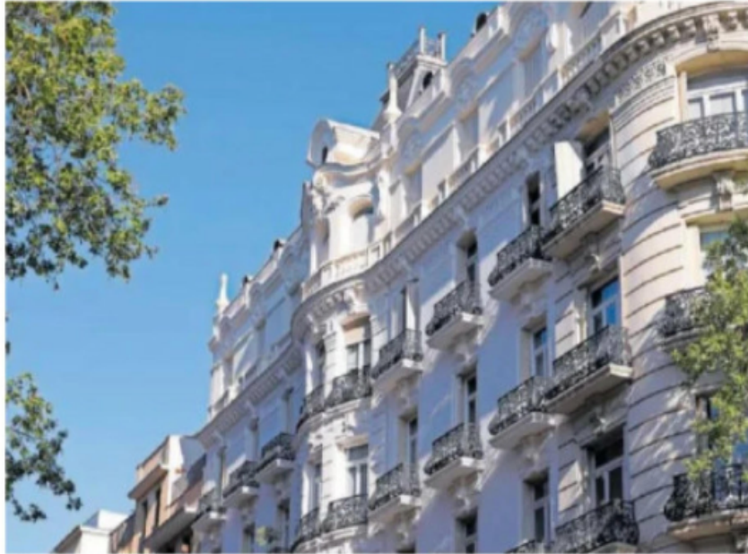
Fachada de un edificio en la calle de Serrano de Madrid. JAVIER LUZON (EFE)
