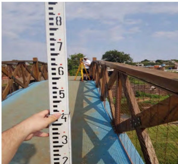
Figura 9: Medição in loco das rampas no Ecopark.
