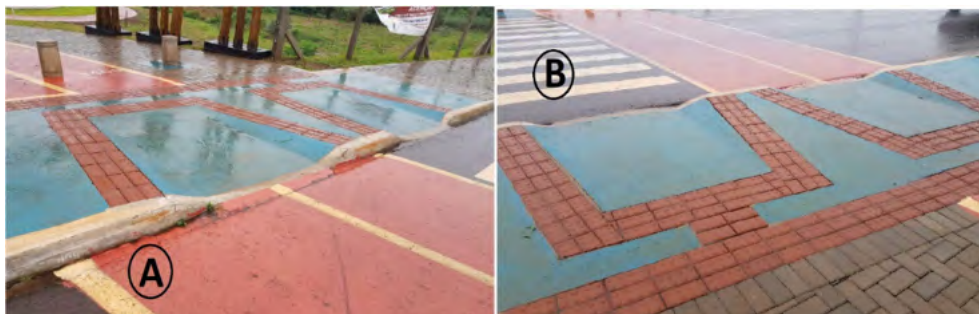
Figura 13: Calçadas com piso podotátil e rebaixamento.
