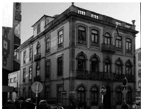
Fig. 4. Perspetiva do edifício onde esteve instalado o Hotel Universal
