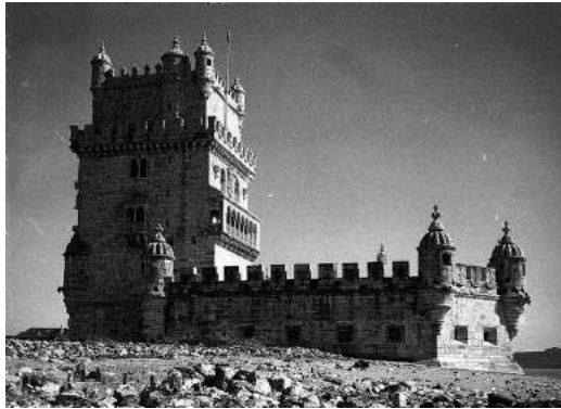
Fig. 2. Lisboa, Torre de Belém, 1955
