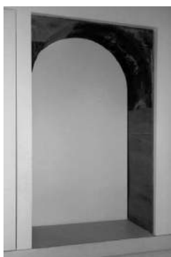
Fig. 3. Antiga capela da Casa da Câmara
