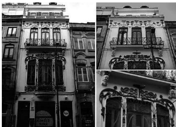
Fig. 3. Edifício da Rua Cândido dos Reis n.º 75-79, em estilo Arte Nova
