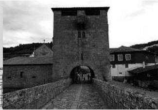
Fig. 3. Torre e Ponte de Ucanha (Tarouca)
