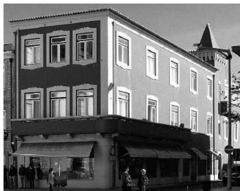
Fig. 5. Perspetiva do edifício onde esteve instalado o Hotel Aura Campista e posteriormente o Hotel Europa
