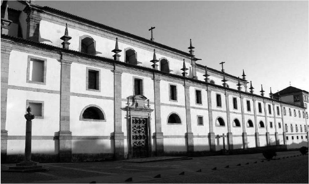
Fig. 2. Fachada da igreja do Mosteiro de Santa Maria de Arouca
