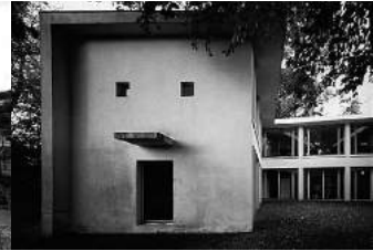
Fig. 4. Topo sul da ala poente do Pavilhão Carlos Ramos – FAUP
