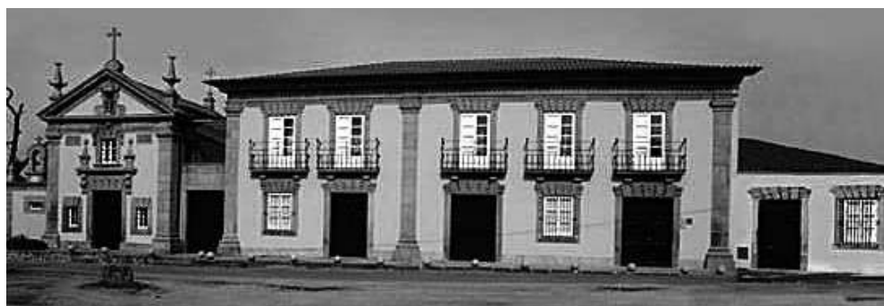
Fig. 3. Casa da Ferreira de Faldejães
