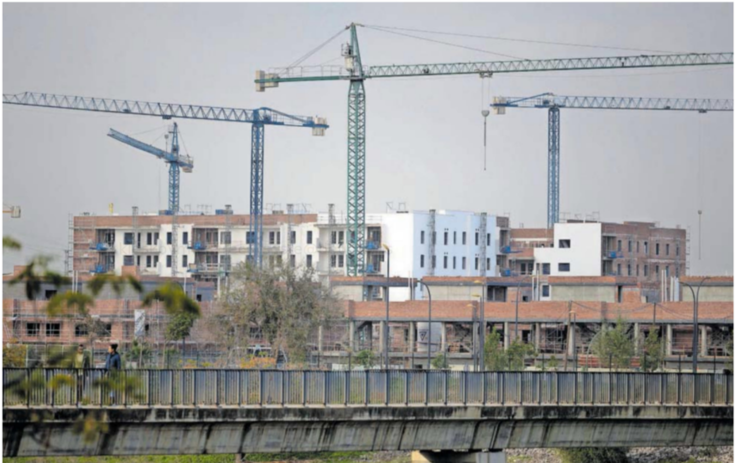
Construcción de viviendas en Sevilla. PACO PUENTES
