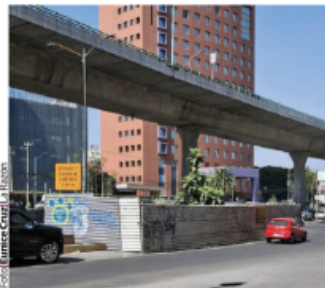
LA ZONA en la que había obras profundas está cercada.
