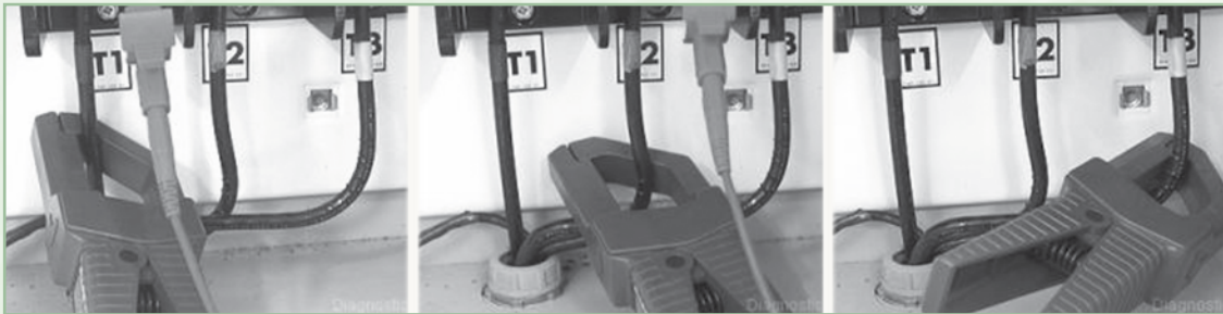
Şekil 12.28. Üç fazın izlenmesi
