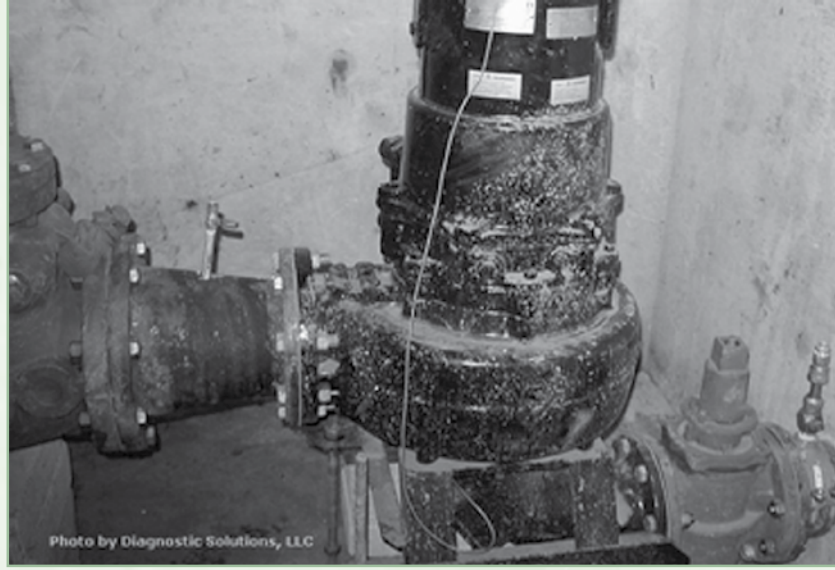
Şekil 12.16. Giriş ve çıkış basıncı ölçüm muslukları-1
