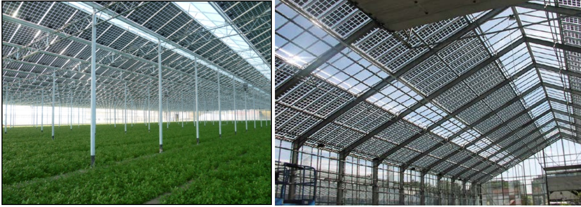
Şekil 1. Seralarda yapıya entegre fotovoltaik sistem (YEFS) uygulamaları
