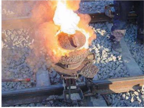
الشكل (3 - 3) استخدام تفاعل الثرميت في لحيم قضبان سكك الحديد.
