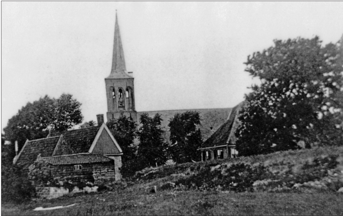
Afbeelding 5.3.121 Een foto uit het eerste of tweede decennium van de twintigste eeuw, tegen de dijk aan stonden meerdere houten huizen op en ten oosten van het meest noordelijke perceel. Deze werden uiteindelijk in 1916 bij een verbreding van de dijk, gesloopt. Foto: geschiedenisschellinkhout.nl
