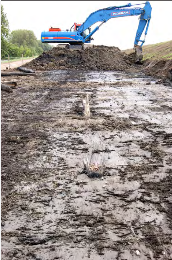
Afbeelding 5.1.8 Op meerdere locaties werden palen in de kern van de dijk teruggevonden. Deze zijn waarschijnlijk het restant van de verankering van de wierriem in de dijk. Deze foto is genomen in Venhuizen net ten oosten van de Elbaweg. (waarneming 124)
