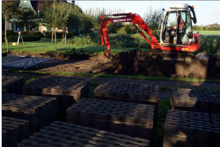
Afbeelding 5.4.23 Tijdens de aanleg van een parkeerplaats werden enkele mogelijk 17de eeuwse muurresten aangetroffen. Foto is richting het westen genomen.
