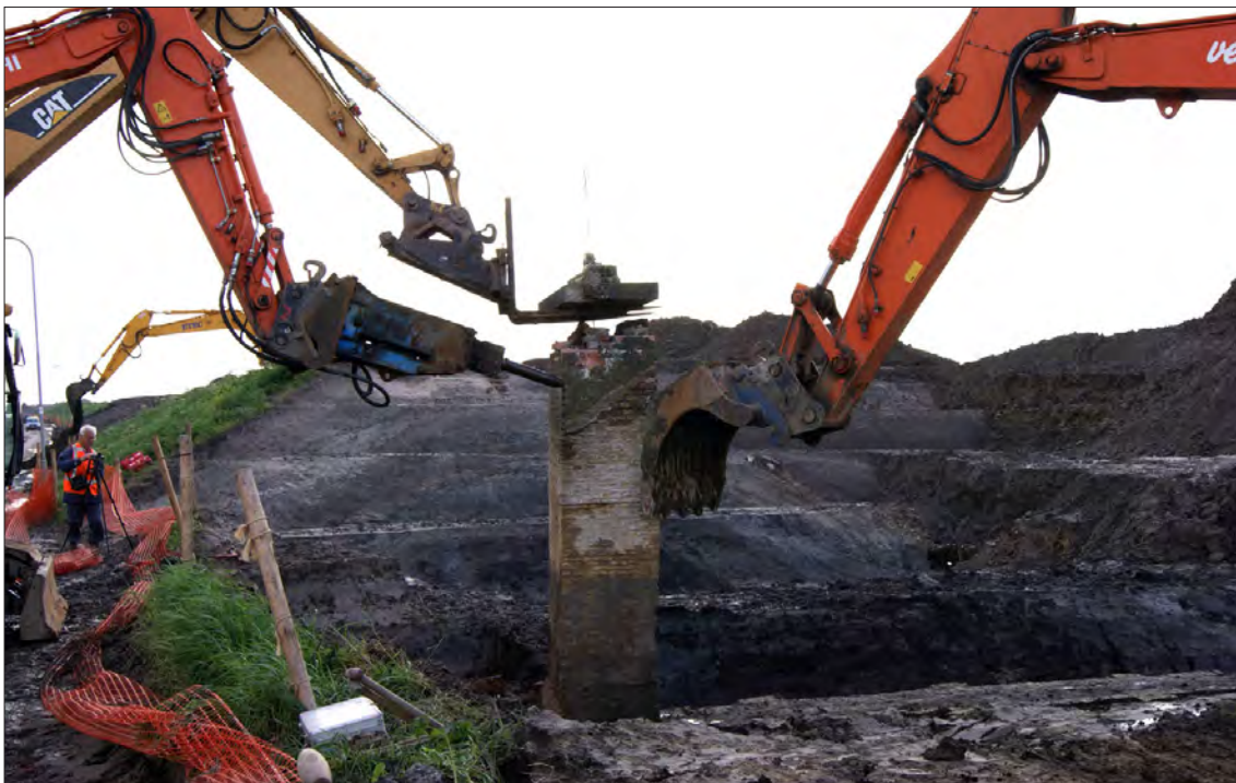
Afbeelding 5.6.3 De sloop van de Spuiter in 2011. Met beleid wordt de deksteen van de binnendijkse schuif verwijderd. Op de achtergrond is de doorsnede door de dijk zichtbaar.
