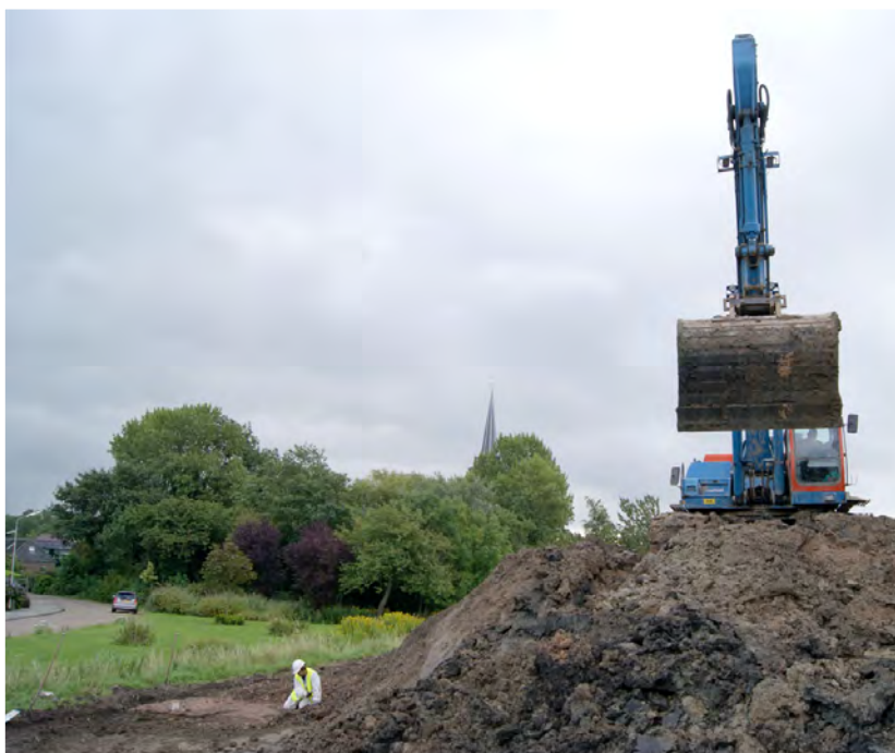
Afbeelding 5.3.44 Werk in uitvoering. Onder de jongere ophogingslagen van de dijk komen de plavuizen vloerdelen tevoorschijn van vindplaats 3.3.
