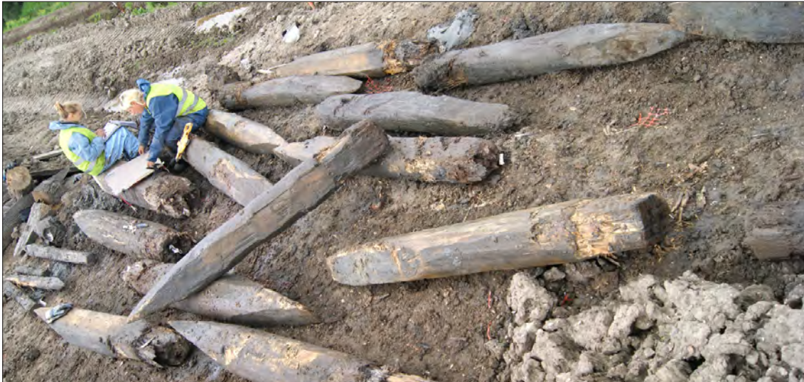
Afbeelding 5.4.19 Werk in uitvoering. Nadat de palen zijn gelicht en schoongemaakt, worden alle afmetingen en opvallende zaken gedocumenteerd.
