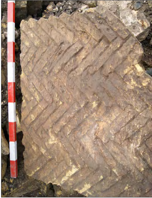
Afbeelding 5.6.5 De vloer van de Spuiter was opgebouwd uit gele bakstenen, neergelegd op de strekzijde in een visgraat- of kepermotief.
