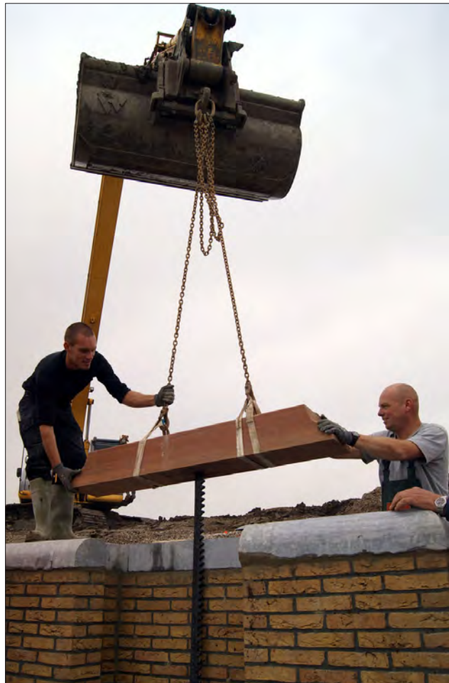
Afbeelding 5.6.7 Na de sloop en hermodellering van de dijk werden de schuifsystemen weer opgebouwd en afgedekt met de originele gerenoveerde dekstenen. Hier de werkzaamheden aan de buitendijkse schuif.
