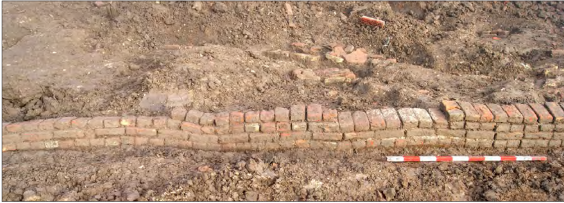
Afbeelding 5.3.14 Op een aantal plaatsen was de fundering onder het gewicht van de wandstijlen verzakt.
