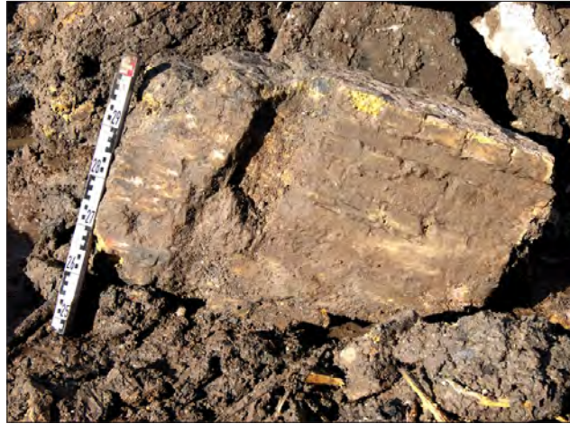
Afbeelding 5.6.6 Na de sloop werd er groot fragment van de ingang van de koker met een gleuf gevonden. Mogelijk kon hierin een houten schot worden geschoven om het water tegen te houden.
