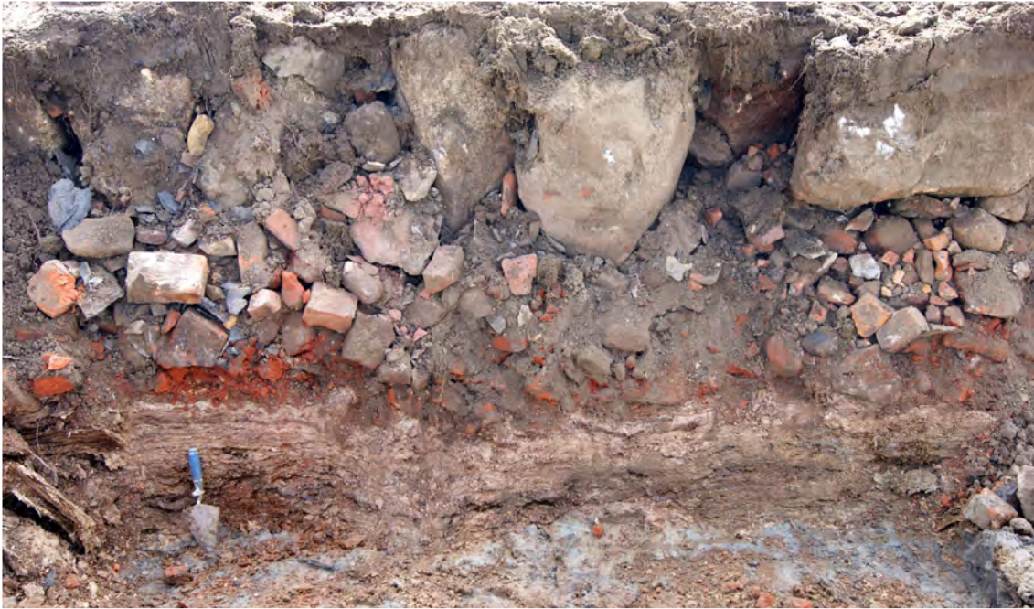
Afbeelding 5.1.9 Lengteprofiel in de top van de dijk. Noordse stenen liggen op grof breekpuin. Hieronder is de top van het pakket zeegras zichtbaar. Deze opname werd bij de Tersluiserhoek gemaakt. (waarneming 132)
