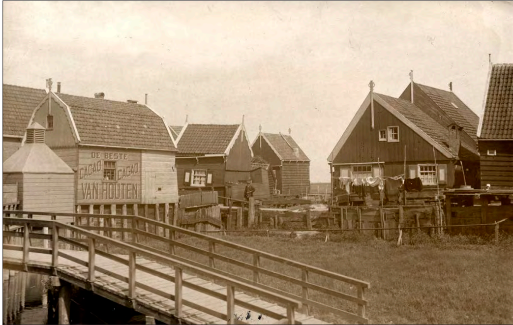
Afbeelding 5.3.141 Foto uit het begin van de 20ste eeuw, genomen op Marken. Aan de rand van dijken en werven (terpen) werden sommige huizen, soms aan een zijde op lange palen gebouwd. Mogelijk werden in Schellinkhout vergelijkbare constructiewijzes toegepast.
