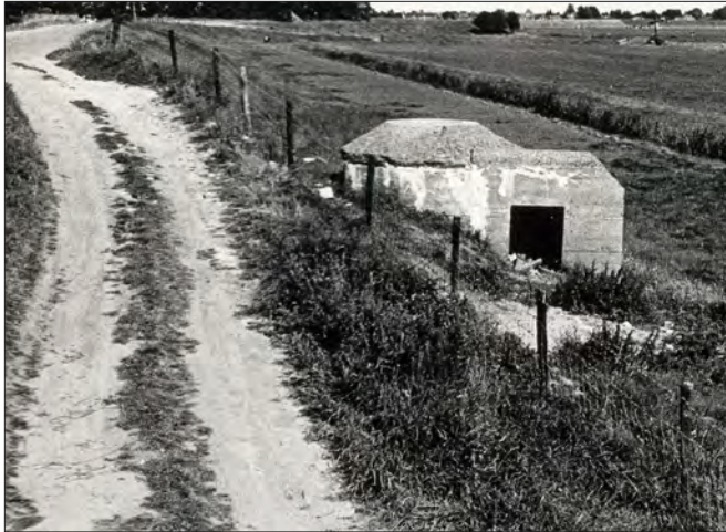
Afbeelding 5.2.16 Een van de bunkers gelegen op het voorland tussen Hoorn 80 en de Munnikei. foto: www.geschiedenis-schellinkhout.nl
