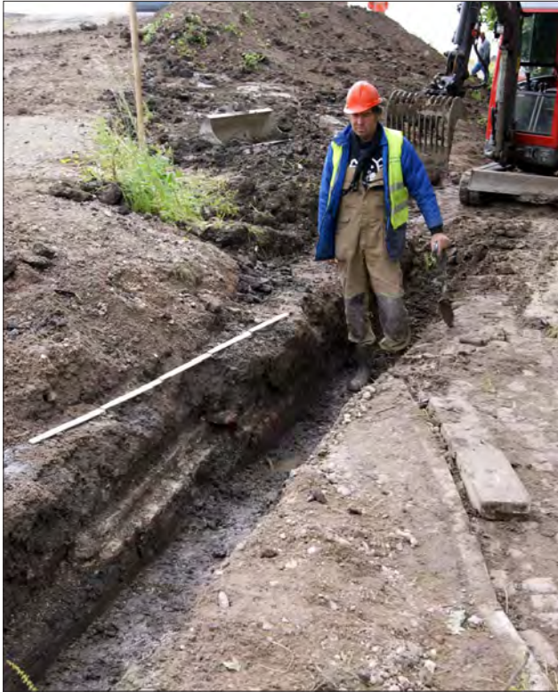
Afbeelding 5.5.35 In een smalle sleuf voor de aanleg van een drain werden resten gevonden van meerdere huizen. Foto is richting het zuiden genomen op perceelnummer 1.
