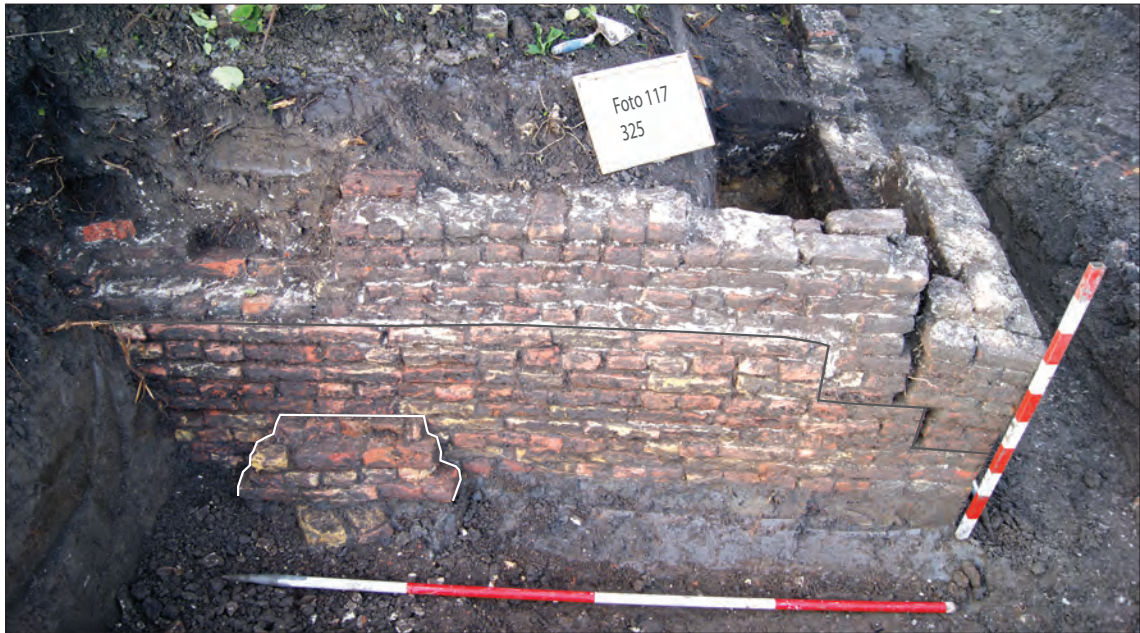
Afbeelding 5.3.8 Aan de oostzijde van het terrein werden de resten van een kelder aangetroffen. De zuidelijke muur was in twee fases opgebouwd (grijze lijn). In de muur van de oudste fase was een poer ingemetseld (witte lijn).
