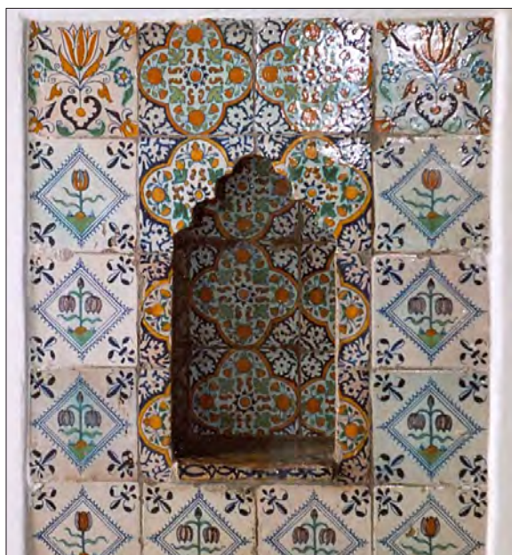
Afbeelding 5.3.88 Nistoptegels bevonden zich aan de bovenzijde van een kaarsnis. Foto uit het St. Pietershof in Hoorn
