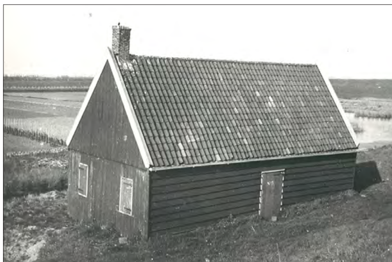
Afbeelding 5.4.5 Het dijkmagazijn werd pas in de 20ste eeuw gesloopt. Op deze foto is te zien hoe de grond van de dijk aan de zuidzijde hoog tegen de zijgevel aanlag. Bron: Archief HHNK.
