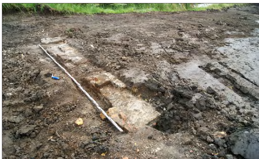
Afbeelding 5.3.37 Bij de begeleiding werden o.a. deze twee poeren met een dichtzetting aangetroffen. Waarschijnlijk was dit onderdeel van een uitbouw.
