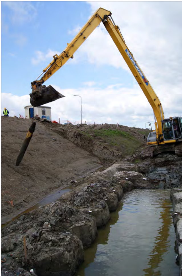
Afbeelding 5.4.18 Met behulp van een dieplepelkraan met verlengde giek werden de palen van het magazijn er uitgetrokken
