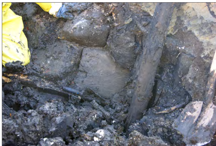
Afbeelding 5.3.136 In de eerste instantie leek het erop alsof Noordse stenen werden gebruikt als versteving, bij nadere inspectie bleek het om hergebruikte brokken natuursteen te gaan.
