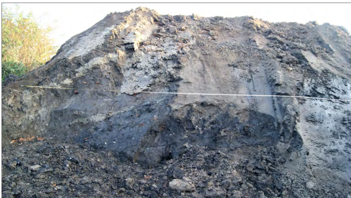
Afbeelding 5.1.6 In een aantal zeldzame gevallen werd tijdens de begeleiding een deel van het dijkprofiel gedocumenteerd. Deze opname werd bij Oosterleek gemaakt. (waarneming 163) Te zien zijn de verschillende ophogingslagen waarmee de dijk in de loop der eeuwen werd verstevigd. De gele lijn is een meetlint.
