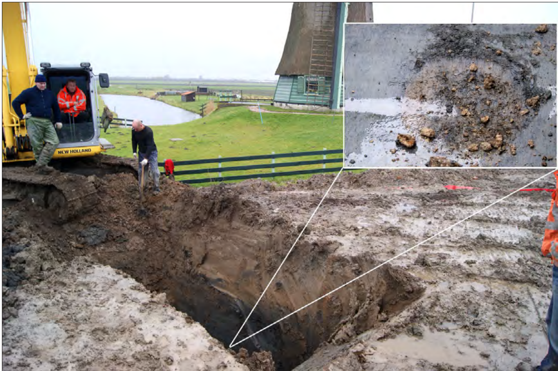
Afbeelding 5.3.131 Bij het verwijderen van een buis van asbest kwam een waterput tevoorschijn die waarschijnlijk buiten gebruik raakte tussen 1575 en 1650. Op de achtergrond is De Grote Molen bij Schellinkhout zichtbaar.
