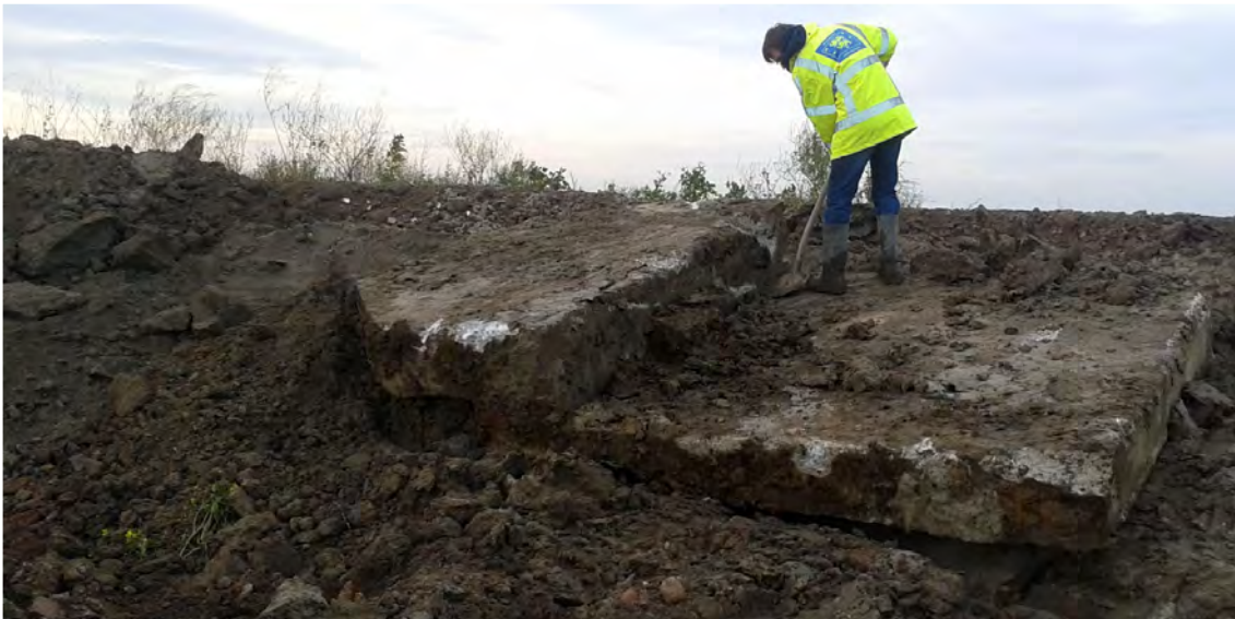
Afbeelding 5.2.13 In de eerste instantie werd bij het aantreffen de betonnen plaat als recent geïnterpreteerd. Pas na het volledig vrijleggen werd duidelijk dat het om de grondplaat van een kleine bunker ging.
