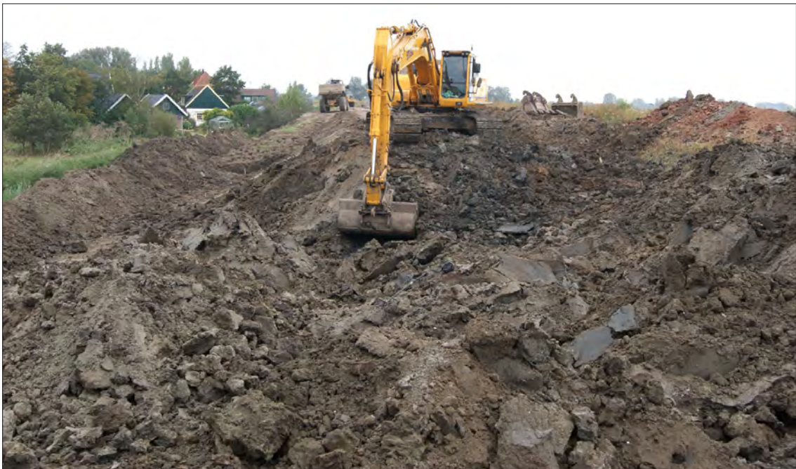
Afbeelding 5.1.12 Op deze afbeelding is goed de schaal te zien waarop de werkzaamheden werden uitgevoerd. In het midden worden de meer erosieve delen van de oude kern uitgegraven. Rechts is er reeds een nieuwe dijk voor de oude aangelegd. Van de originele dijk zal slechts een deel overblijven dat als steunberm tegen de nieuwe aanligt. De foto is ten zuiden van Oosterleek (richting het noorden) genomen. (waarneming 163)
