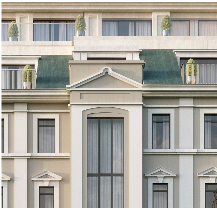
Исторический фасад, медная патинированная кровля
