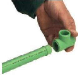
c- Erimiş yüzeyler birleştirilir
