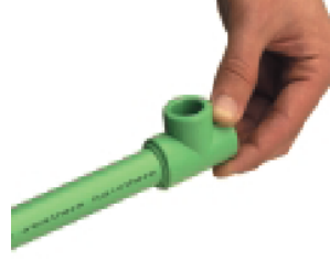
d- Sağlam bir birleştirme için bir süre beklenir
