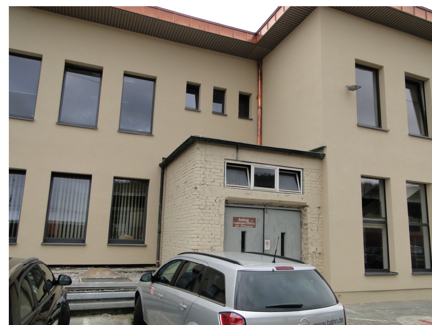
Hausbahnsteig, Blick Richtung Empfangsgebäude, Pkw-Stellplätze, Lastenaufzug, keine barrierefreie Erschließung des Empfangsgebäudes möglich
