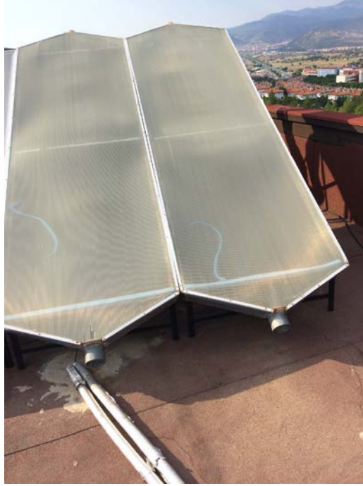
Şekil 1. Selektif Yüzeyle Havalı Güneş Kolektörü
