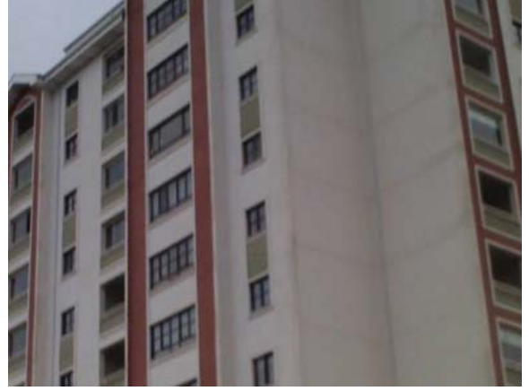
Şekil-31. Yalıtım öncesi sol yan üst fotoğrafı
