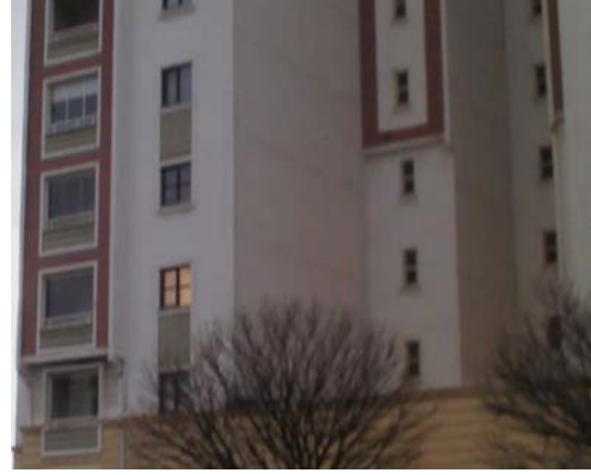
Şekil-13. Yalıtım öncesi ön sol alt fotoğrafı
