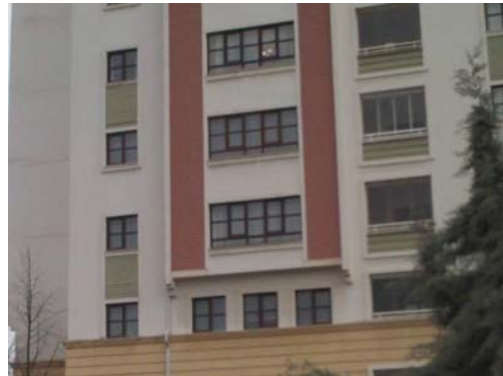
Şekil-25. Yalıtım öncesi sağ alt fotoğrafı
