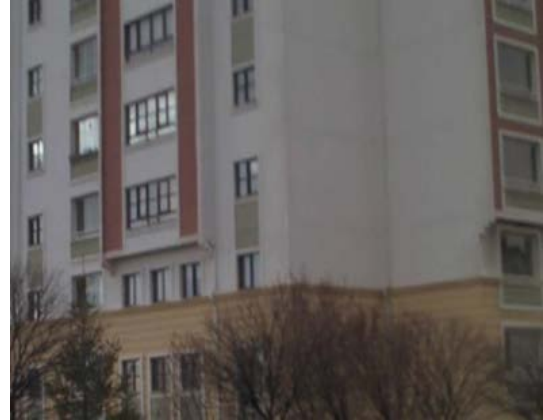
Şekil-33. Yalıtım öncesi sol alt fotoğrafı
