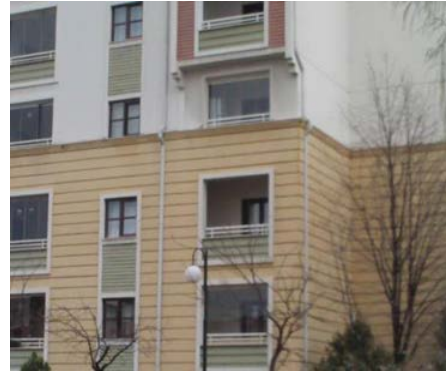
Şekil-23. Yalıtım öncesi sağ alt fotoğrafı
