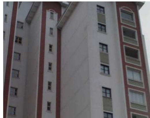
Şekil-15. Yalıtım öncesi ön sağ üst fotoğrafı
