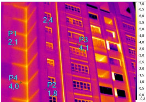
Şekil-26. Yalıtım öncesi arka üst termal ölçümü
