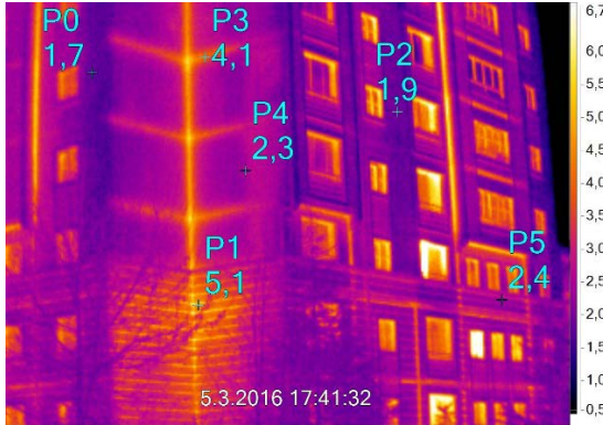
Şekil-48. Yalıtım öncesi sol yan termal ölçümü
