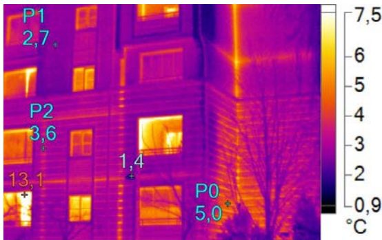
Şekil-40. Yalıtım öncesi sağ alt termal ölçümü
