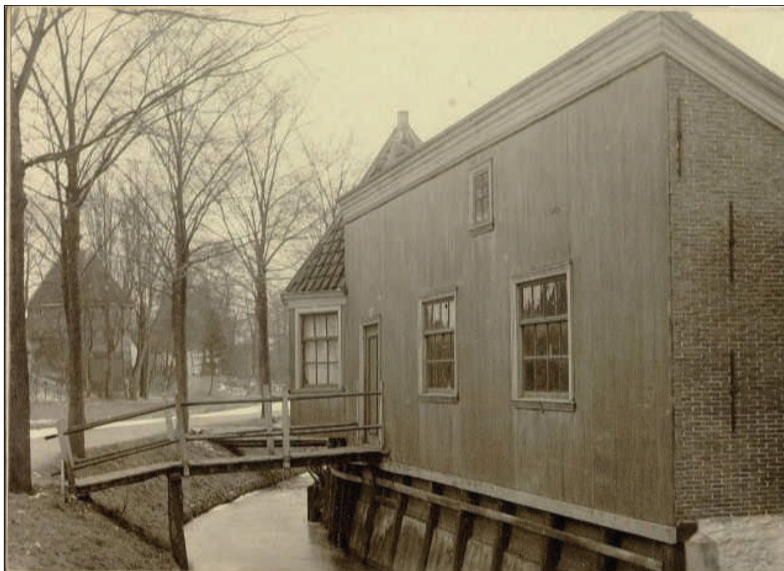
Afb. 116. Tuinhuis aan de Draafsingel rond 1900 (collectie Westfries Archief). Het tuinhuis staat op houten palen in de sloot en heeft aan de tuinkant halfsteens muren en aan de slootkant een houten wand. Typerend is ook het aflopende dak.
