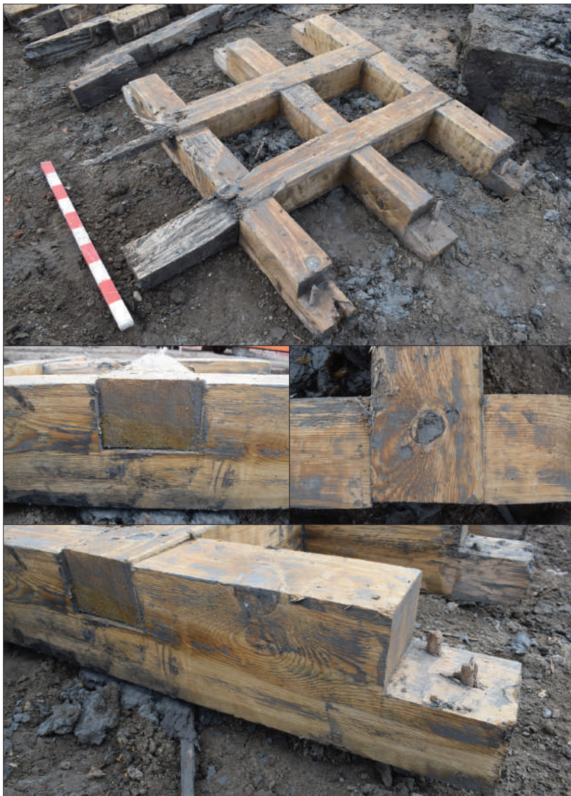
Afb. 57. Detailfoto's van de houtconstructie van de balkenfundering van de waterkelder. Hierop lagen houten planken en daarop was de bakstenen vloer van de kelder geplaatst.
