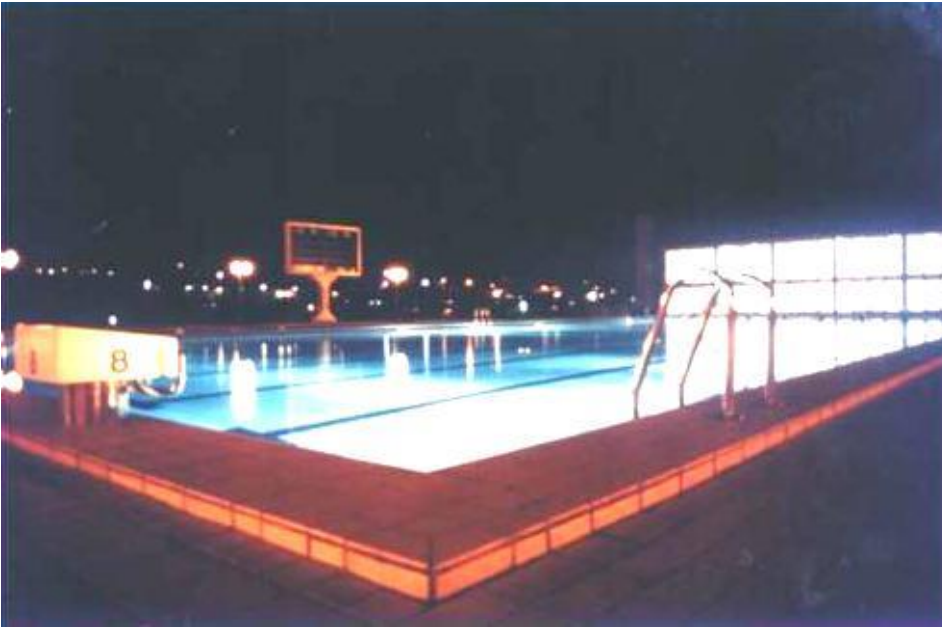
AÇIK OLİMPİK YÜZME HAVUZU Sadı Gülçelik Spor tesisinin gündüz ve gece görünümü
