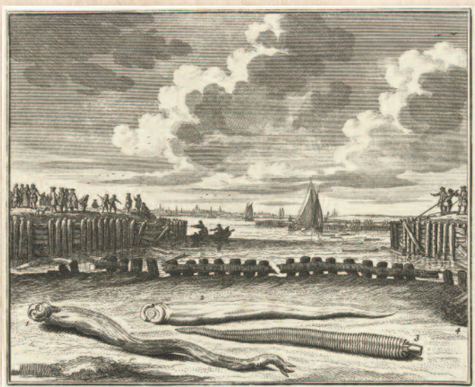
Prent van Abraham Zeeman (1731): De ontdekking van de paalwormen die de dijkbeschoeiingen aantasten. Op de voorgrond drie exemplaren van de paalworm.
