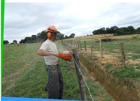
La pose des barbelés s'enchaîne en partant de haut en bas en respectant un espacement de 25 cm avec une cale. La finition consiste à couper l'excédent du piquet à la tronçonneuse.
