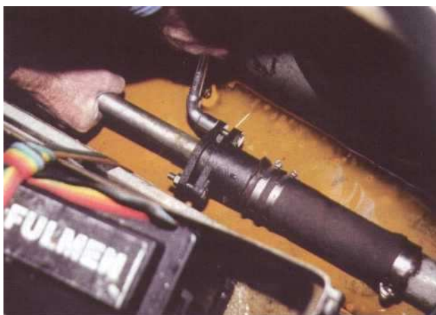
1 Dévissez le fouloir. Remarquez la quantité et la couleur de l'eau dans la cale, fuite d'eau, fuite d'huile. Un bon nettoyage et une bonne révision s'imposent.
