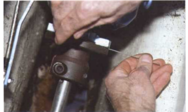
4 Comparez ensuite les dimensions des intervalles B, C et D. Si le désalignement est supérieur à 5 microns par centimètre de diamètre de tourteau, il faut réaligner la position du moteur et de l'inverseur par rapport à l'arbre d'hélice. Rappelons que l'alignement latéral du moteur par rapport à l'arbre d'hélice s'opère en dévissant les écrous des tire-fond de fixation des silent blocs et l'alignement en hauteur en modifiant la hauteur des pattes de fixation par rapport aux silent blocs.
