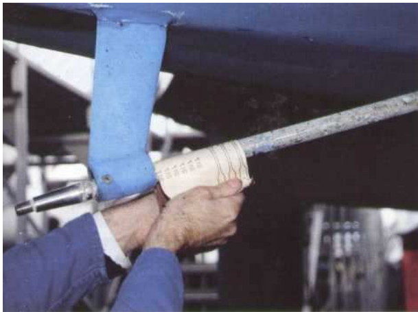
b Avant de rentiler une nouvelle bague, un petit de nettoyage au papier de verre s'impose.
