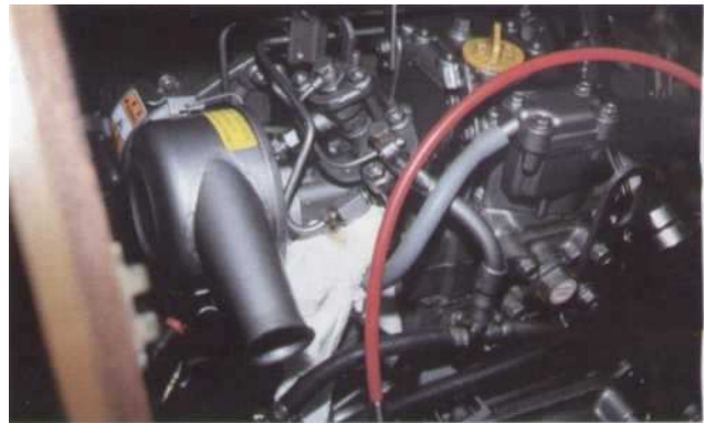
2 Un chiffon blanc glisse sous le tuyau permet de visualiser le demi injecté tout en évitant au gazole de tomber sur la culasse chaude.
