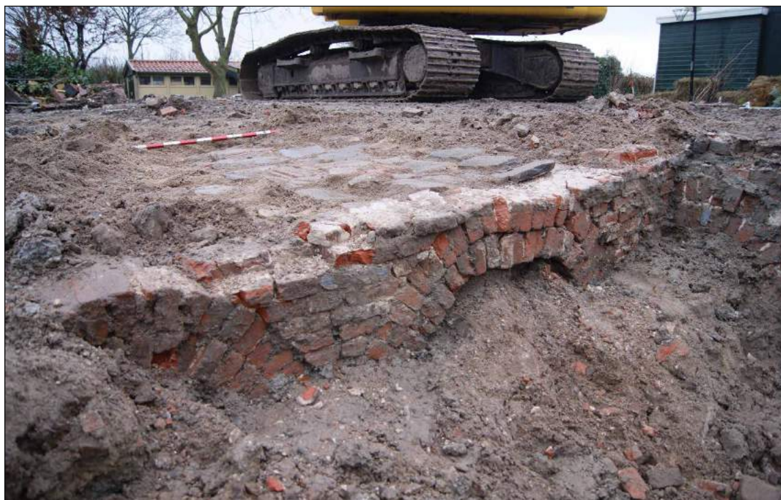
Afbeelding 18. Fundering van een muur tussen de hooiberg en achtergevel.
