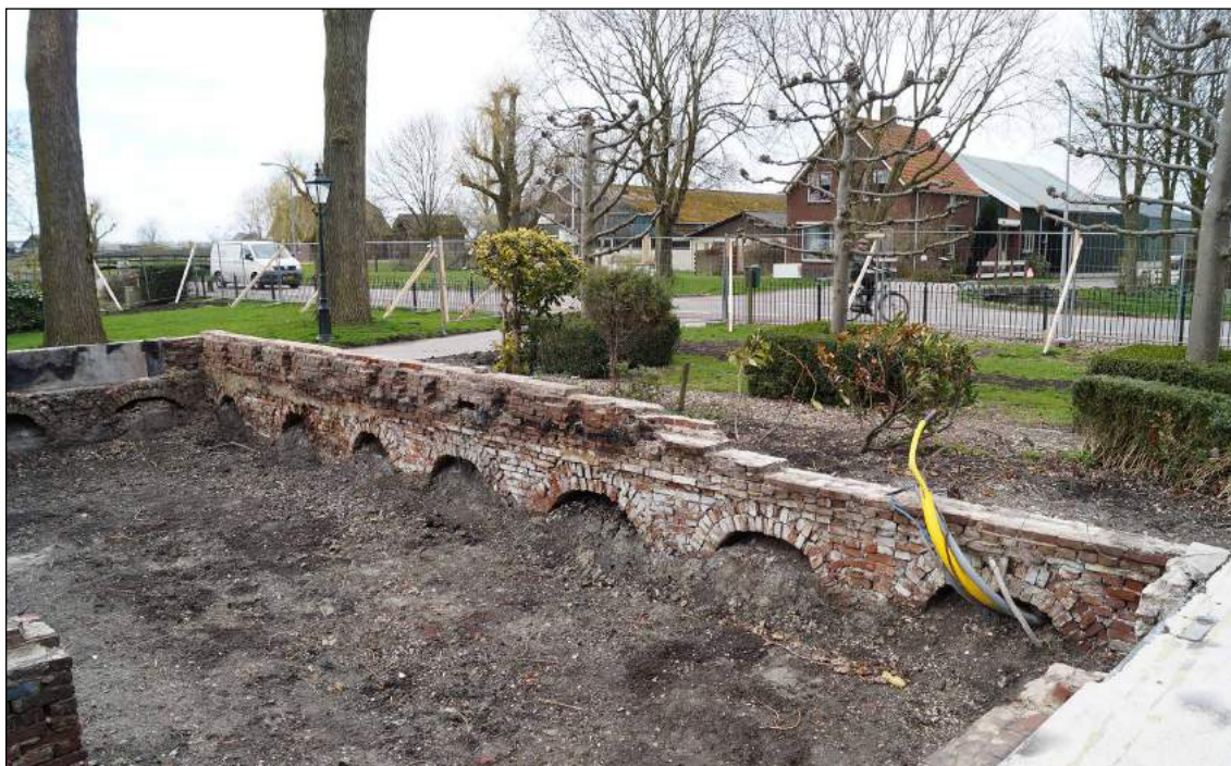
Afbeelding 13. Fundering met spaarbogen van de voorgevel van de boerderij.
