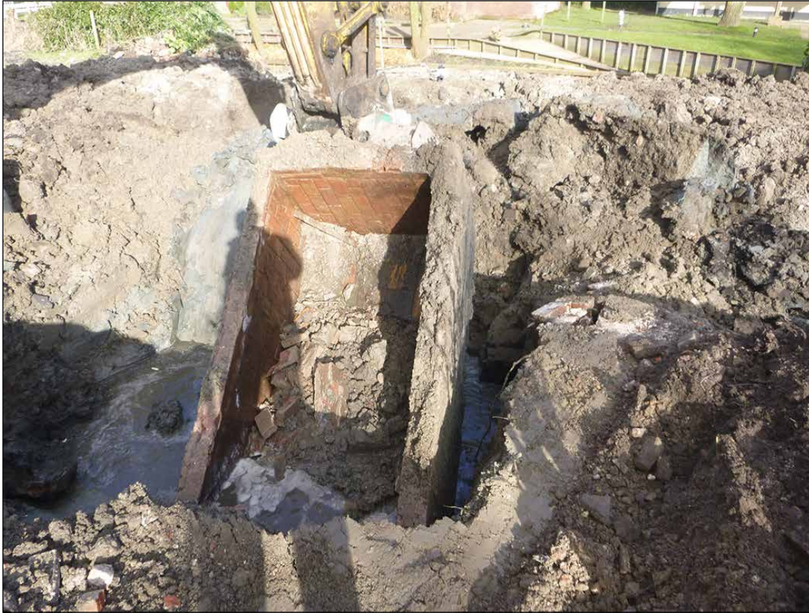
Afbeelding 24. De waterkelder in de schuur.
