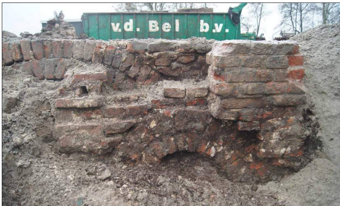
Afbeelding 17. Fundering van de schoorsteen aan de zuidzijde van de boerderij.
