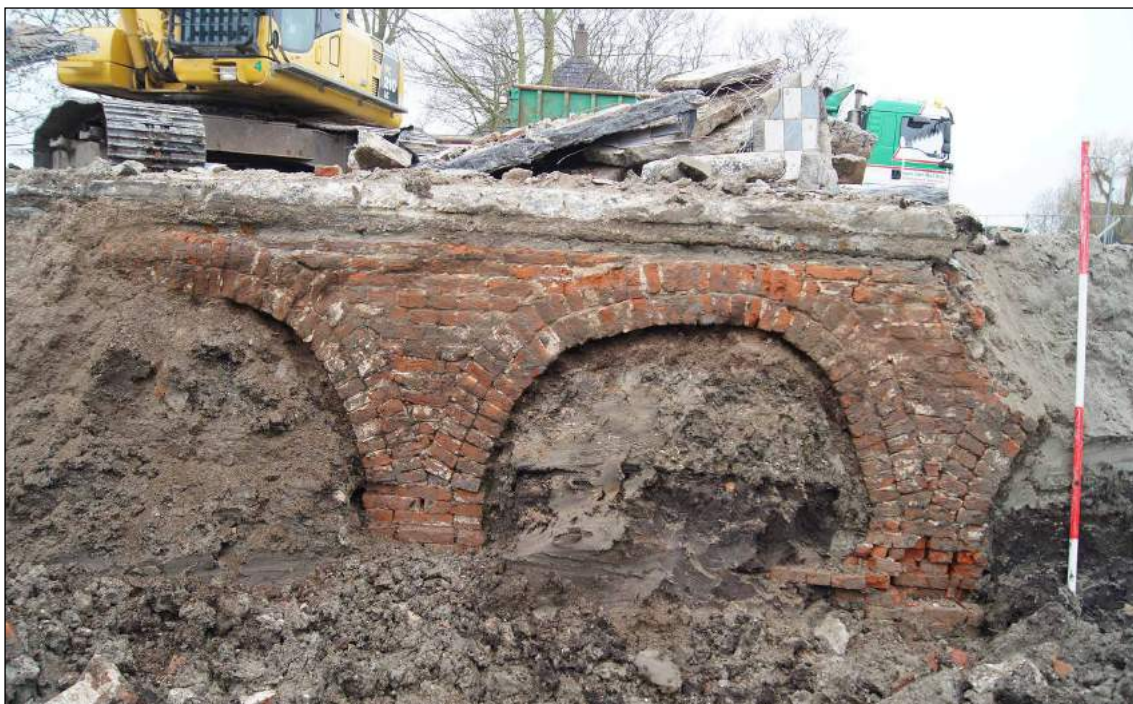
Afbeelding 15. Fundering met spaarbogen S6.
