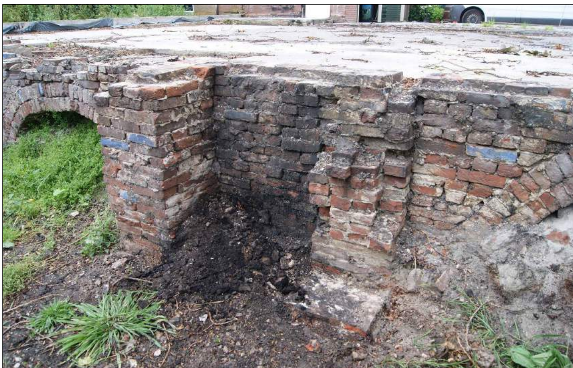
Afbeelding 16. Fundering van de schoorsteen aan de noordzijde van de boerderij.
