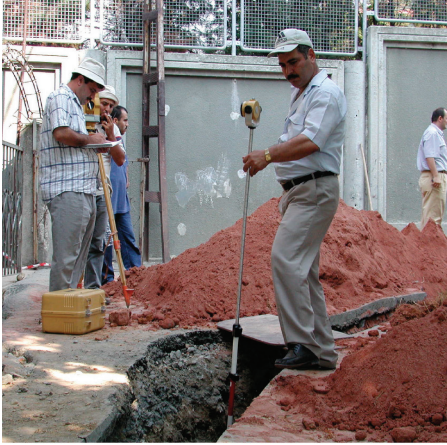
Şekil 13 Çelik Boru Serme ve Ölçüm İşleri
