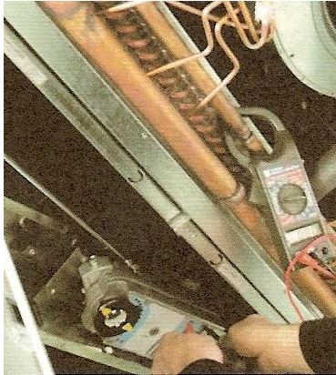
Resim 1.5: Pens ampermetre ile ölçüm yapma
