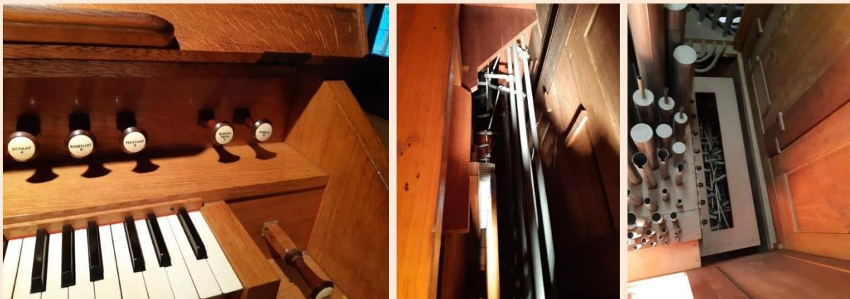
De mechanische registertraktuur bestaat uit metalen walsen en balansarmen. De verbindingsstrekkers zijn van hout en metaal. Alles is degelijk gemaakt, de armen zijn vast geklemd op de walsen zodat er tijdens het gebruik nooit iets kan losgaan of verschuiven. De verbindingen zijn kogelgewrichten.
