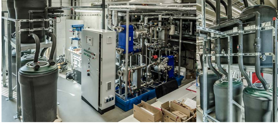
Şekil 3. Buzda depolama uygulaması yapılan bir resorbsiyonlu soğutma sistemi [29]
