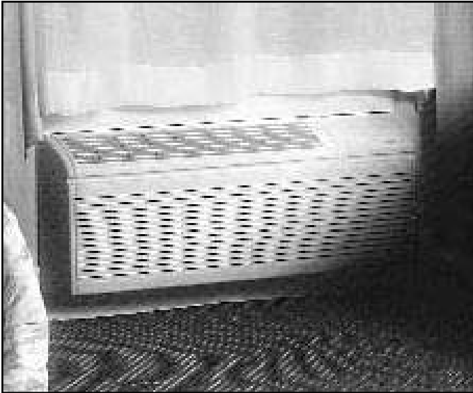
Şekil 12.40. ISISAN AMANA ODA TİPİ PAKET KLİMA (P-TAC)
