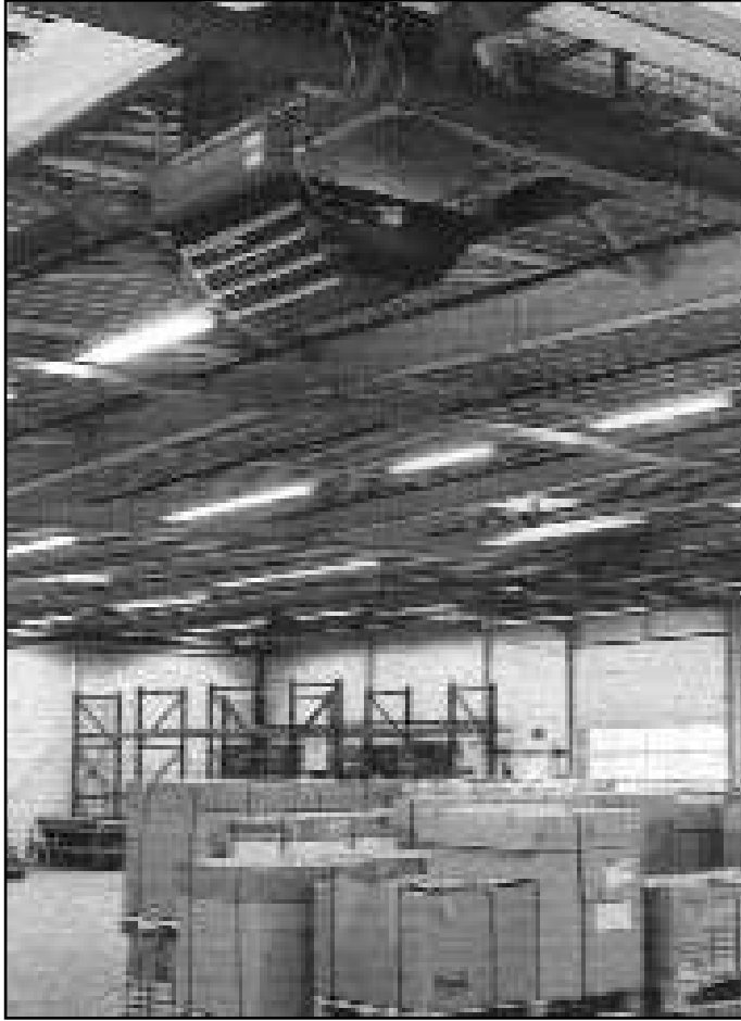
Şekil 17.86. TAVAN TİPİ HAVA APAREYİ
