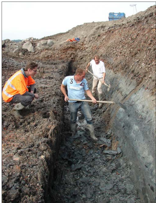
Afb. 22 Opschaven van het lengteprofiel door de dijk
