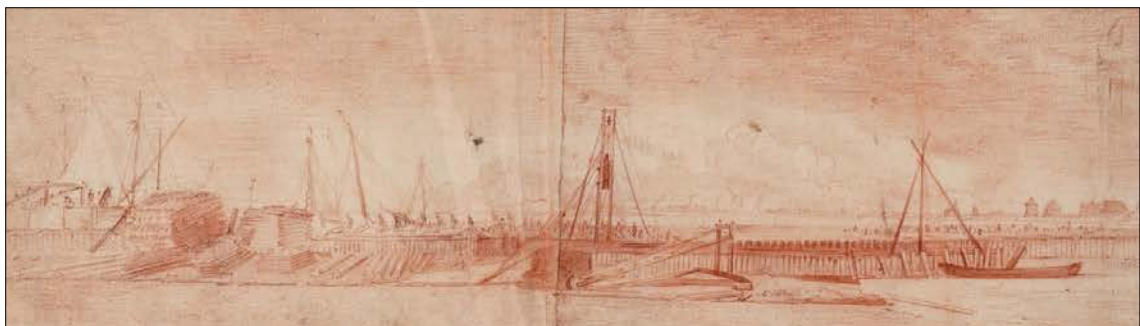
Afb. 36 Herstel van de Omringdijk bij Scharwoude na de stormvloedramp van 1675, Matthias Withoos 1676 (NHA, Prenten en Tekeningen Provinciale Atlas). Duidelijk zichtbaar zijn de installaties die werden gebruikt om de zware palen te heien.
