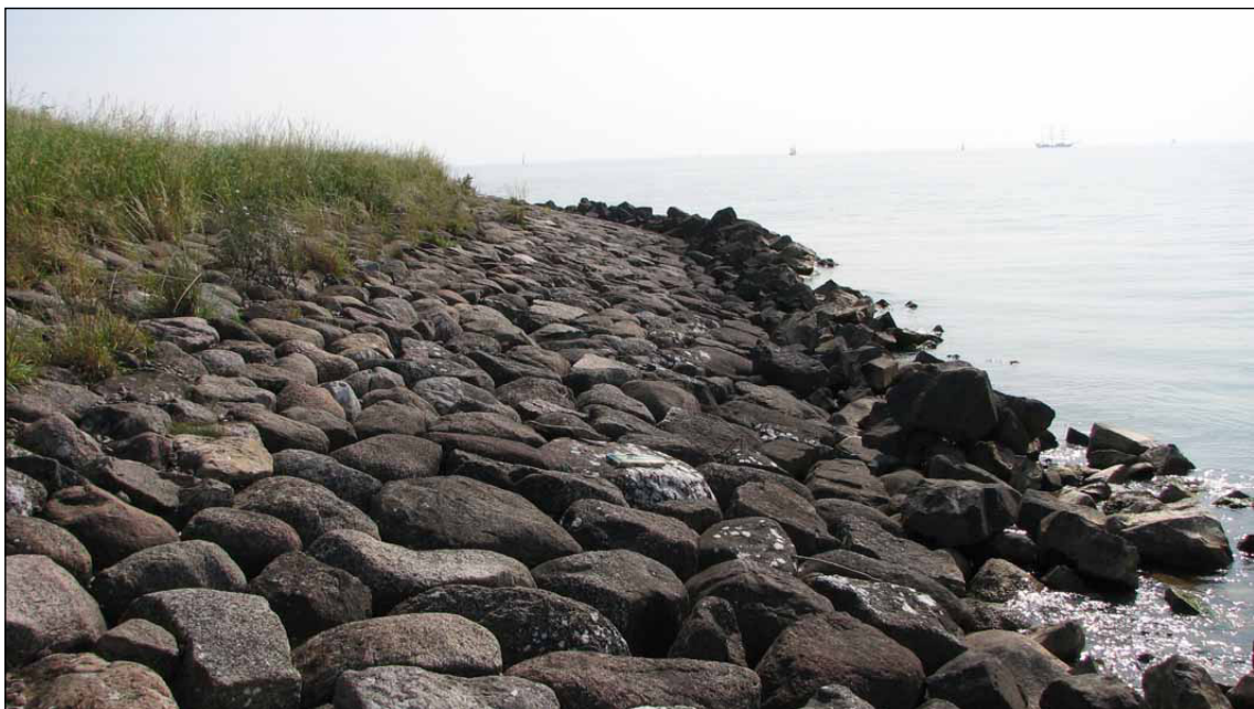
Afb. 40 Een deel van de Schellinkhouderdijk voorafgaand aan de dijkwerkzaamheden. De dijk is bekleed met Noorse keien.
