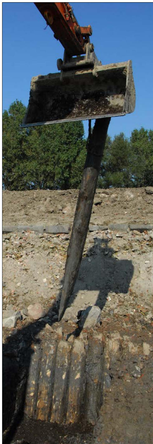
Afb. 31 Het trekken van een paal (circa 4 meter lang) ten behoeve van bemonstering voor dendrochronologisch onderzoek.
