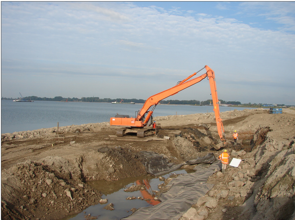
Afb. 2 Aanleg vlak 1 van werkput 1, met op de achtergrond het water van het Hoornse Hop
