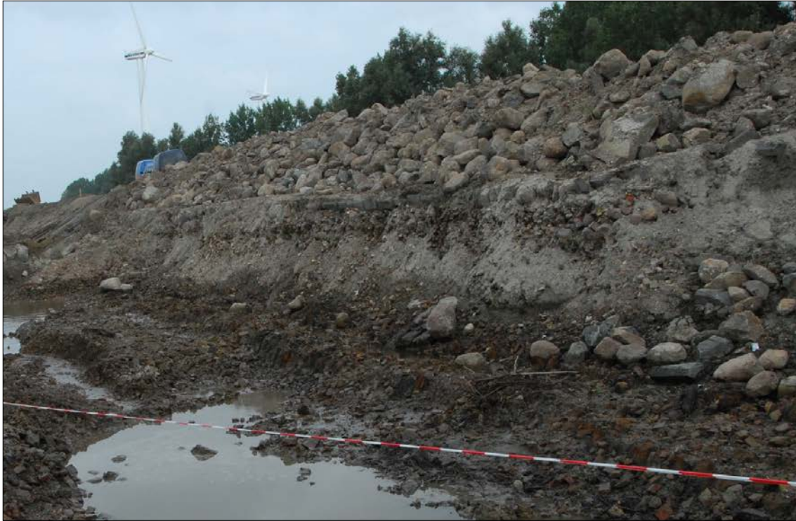
Afb. 28 Voorafgaand aan de opgraving in september 2008 waren de Noorse keien die vanaf de 18de eeuw als dijkbekleding hebben gefungeerd nog aanwezig. Deze zijn in verband met de veiligheid tijdens de opgraving verwijderd.
