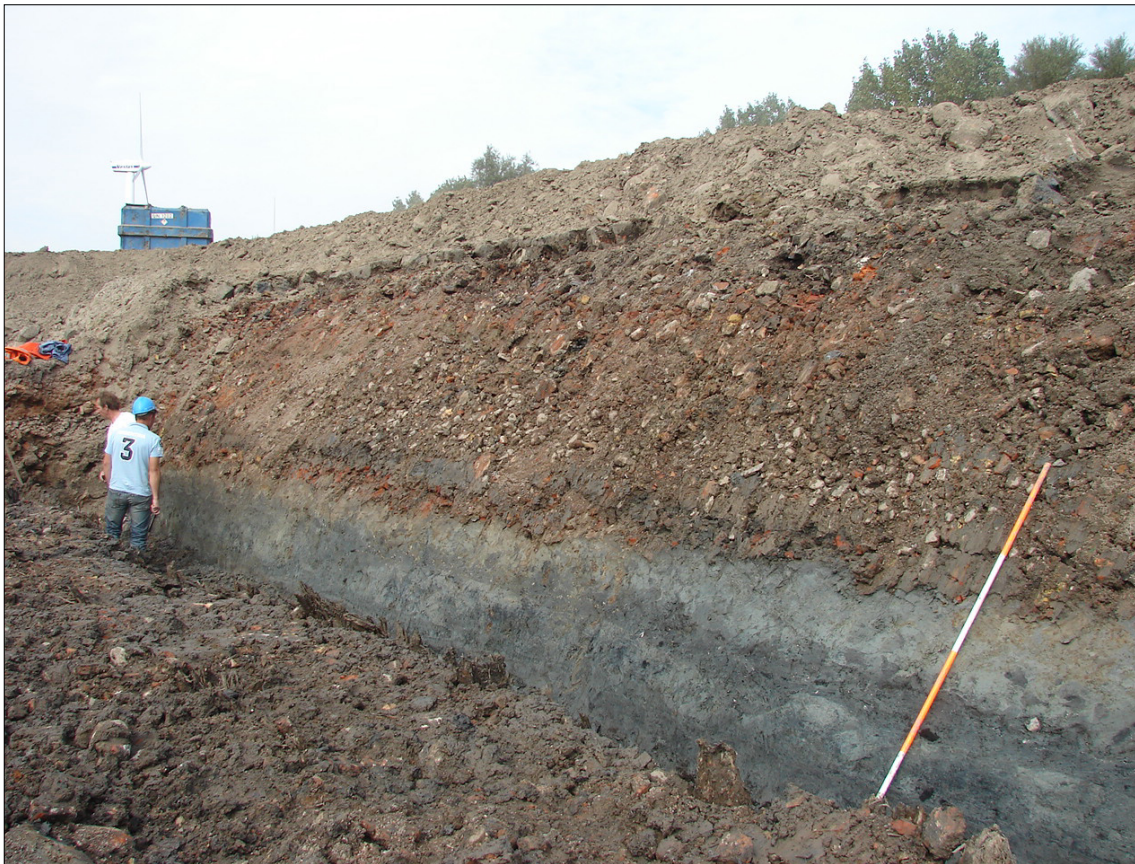
Afb. 26 Het lengteprofiel door de dijk met onderin de kleiophogingen en bovenin de diverse pakketten puin uit de 19de eeuw
