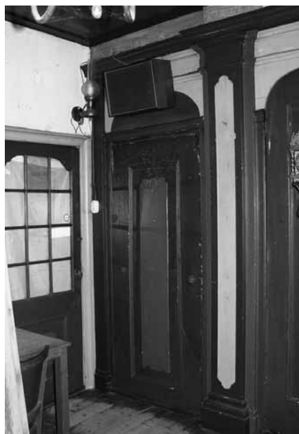
Rechts een gedeelte van de bedstedewand, links de deur naar het voorhuis.
