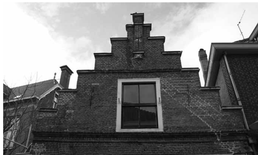
De trapgevel van Westerstraat 113 in april 2012, na de restauratie.
