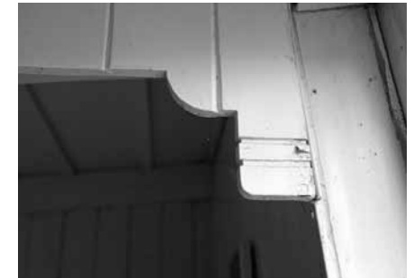
Detail van de betimmering van de bedstede.
