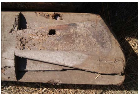
Afb. 27 Uiteinde van de bovenste dekbalk aan de noordkant. Aan de bovenzijde is een inkeping voor de overstekbalk aanwezig.
