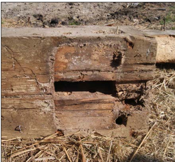
Afb. 22 Rechthoekig gat in de onderzijde van een onderste dekbalk. Hierin werd de pen van een vierkantstijl ingelaten.
