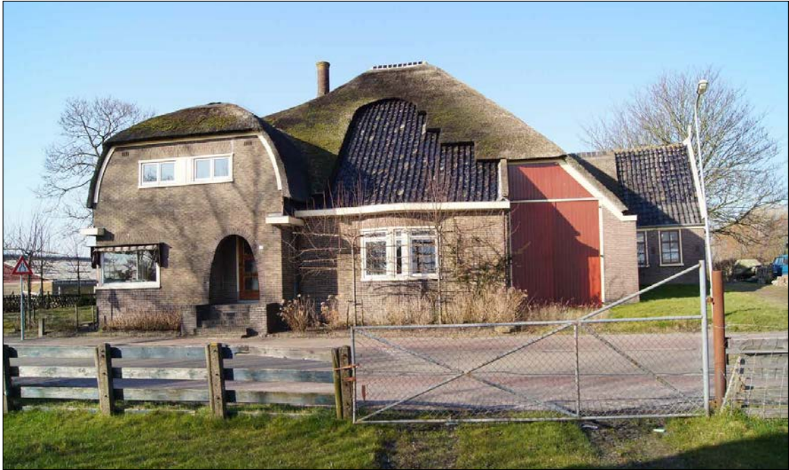
Afb. 12 De voorgevel (zuidgevel) van de voorste stolpboerderij.
