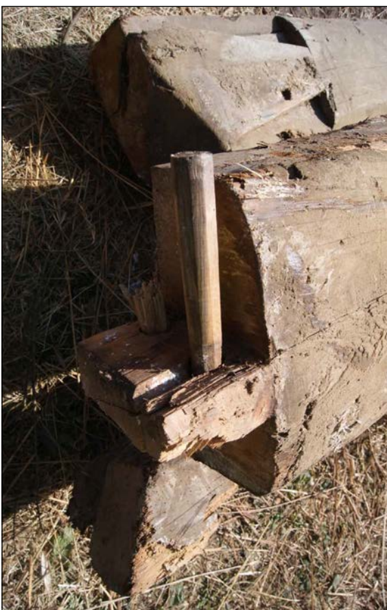
Afb. 23 De rechthoekige pen aan de bovenzijde van een vierkantstijl, met eiken toognagels.
