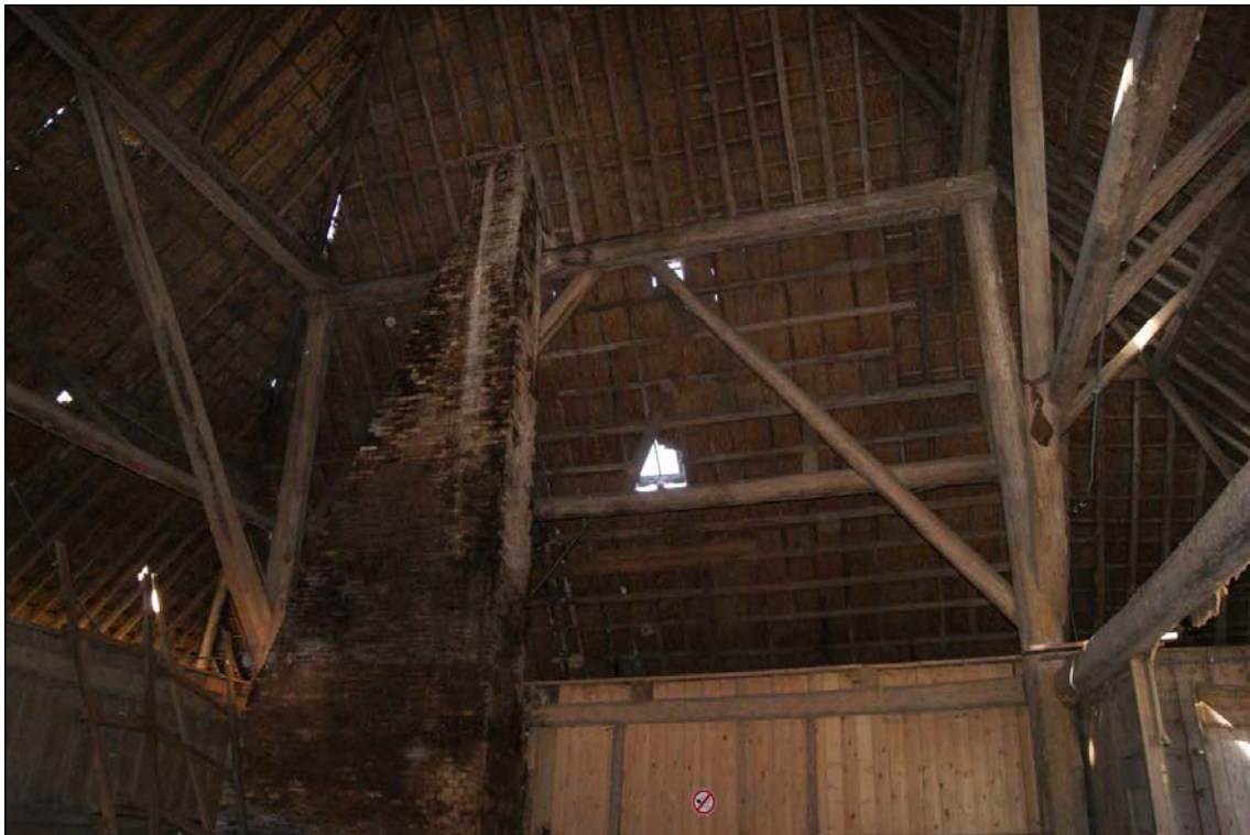
Afb. 44 De westzijde van het vierkant met jaagbalk en enkele zwiepingen.
