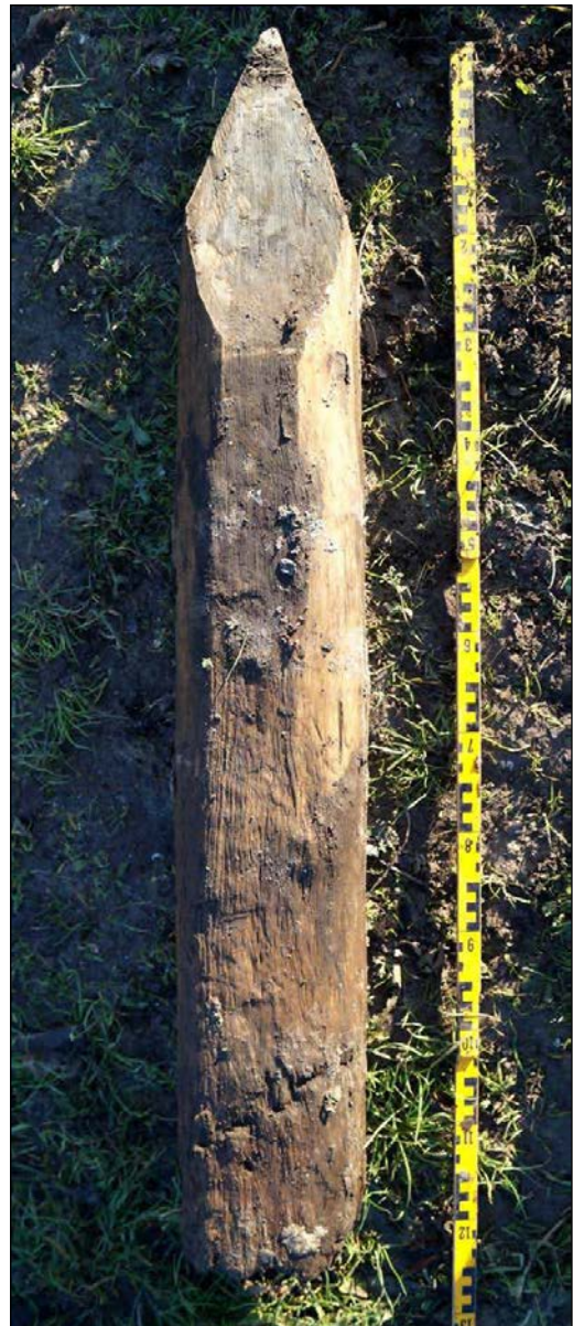
Afb. 73 Onder vierkantspoeren van de tweede stolp kwamen twee aangepunte palen tevoorschijn, namelijk deze van eiken (boven) en naaldhout (rechts).
