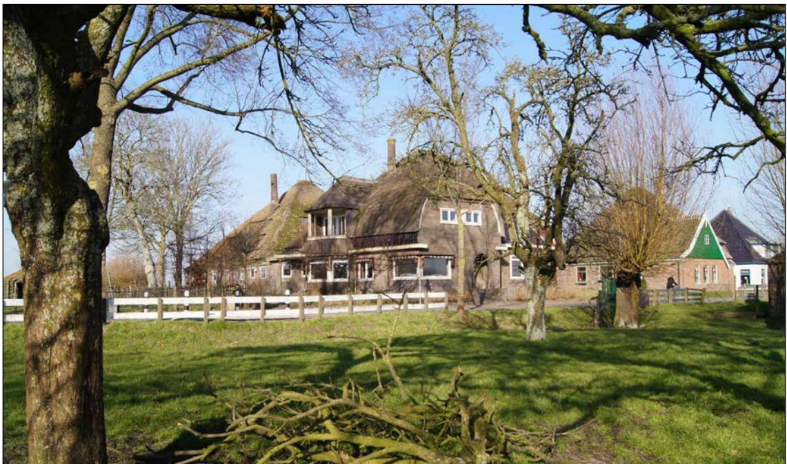
Afb. 80 De stolpboerderijen voor de sloop.
