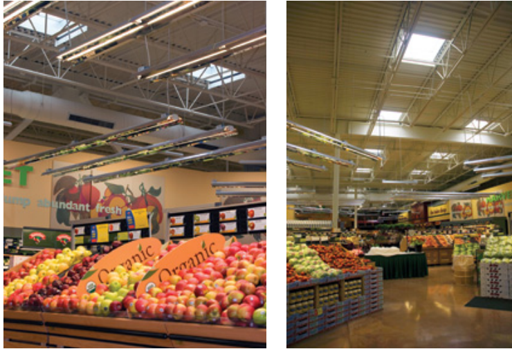
Şekil 4. Aydınlatma için kullanılan Lumira aerogel paneller (Wasco skylights, 2015).
