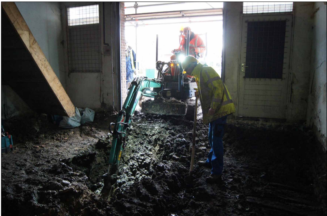
Afb. 10 Het uitgraven van de vetvangput.
