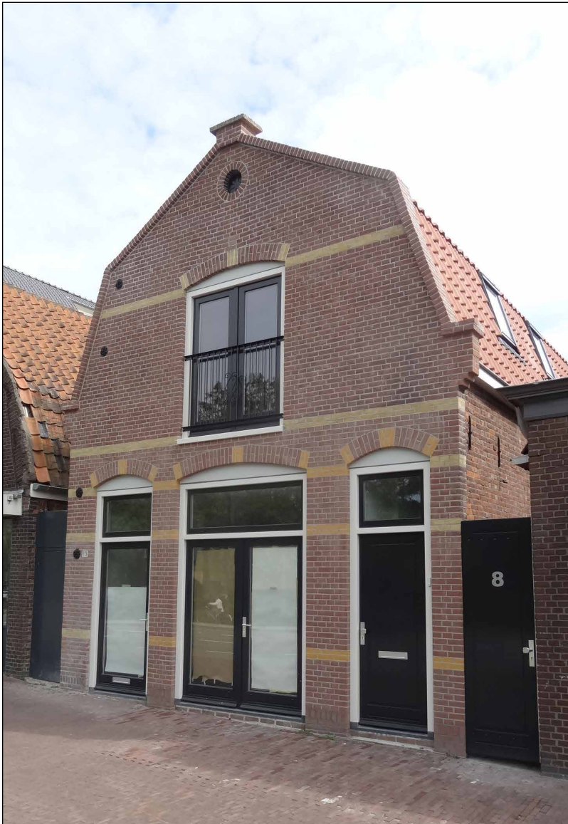
Afb. 2 Scharloo 10 na de verbouwing.
