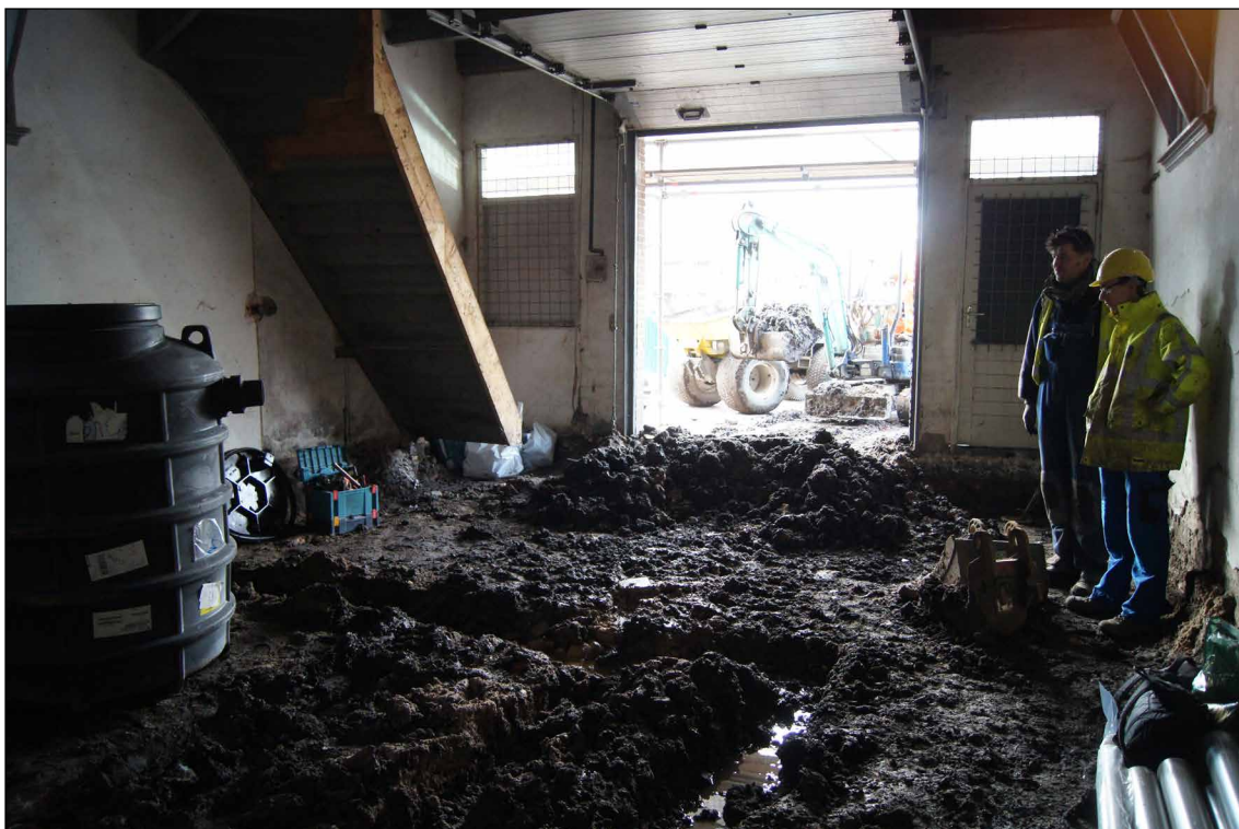
Afb. 3 Scharloo 10 tijdens het uitgraven, kijkend richting de voorgevel.
