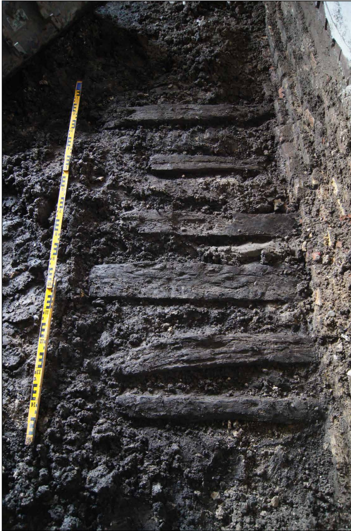
Afb. 12 Fundering van eiken balkjes onder de noordmuur, kijkend richting de voorgevel.
