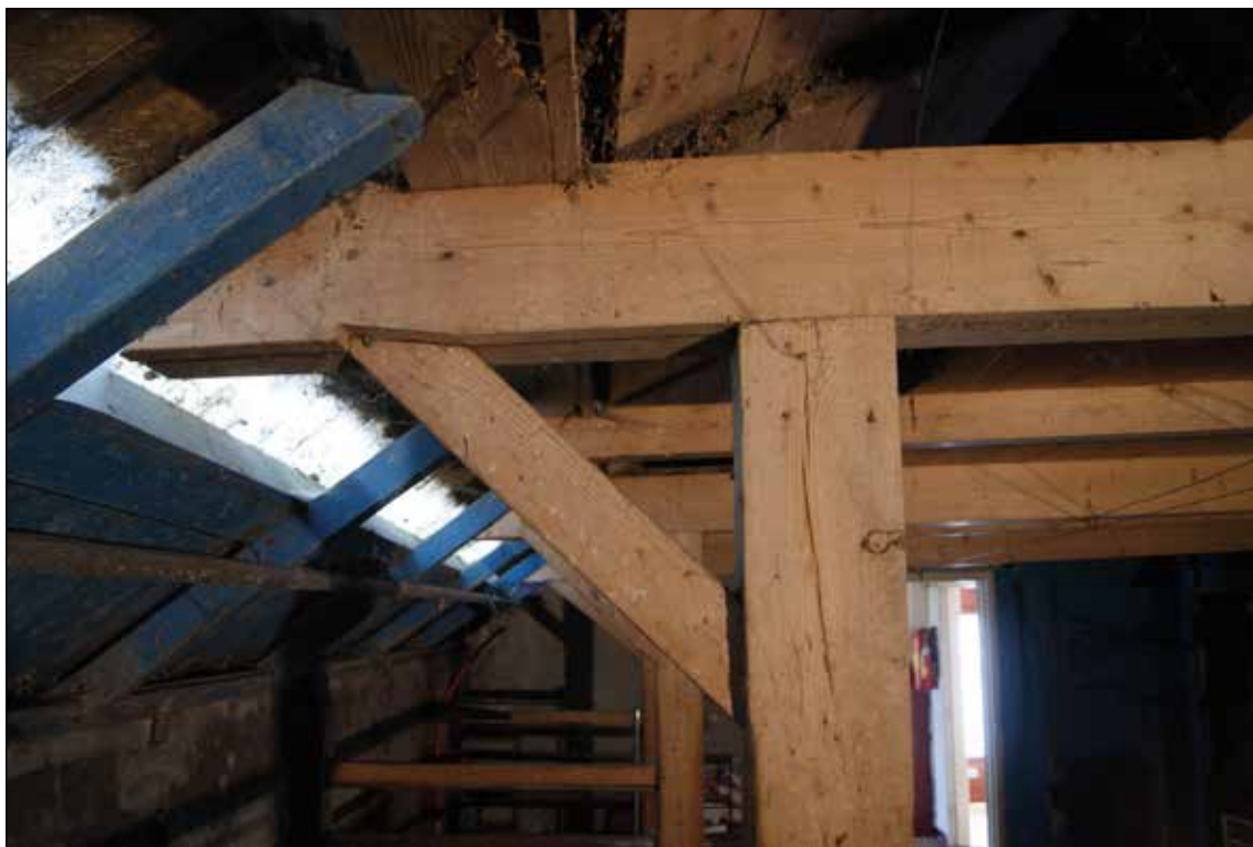
Afb. 40. Detail van de zolderbalken en koestijlen in de stal.
