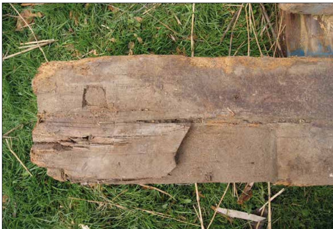
Afb. 50. Detail van de overstekbalk, met onderin een lege lipverbinding met hak. Deze houtverbinding had geen functie in het vierkant.
