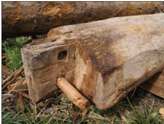
Afb. 52. Bovenkant van een van de stijlen met een pen en twee (gaten voor) toognagels.
