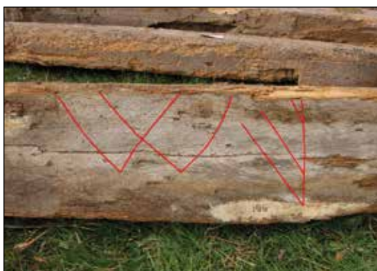
Afb. 62. Merken (in rood geaccentueerd) op de onderkant van de noordelijke dekbalk.
