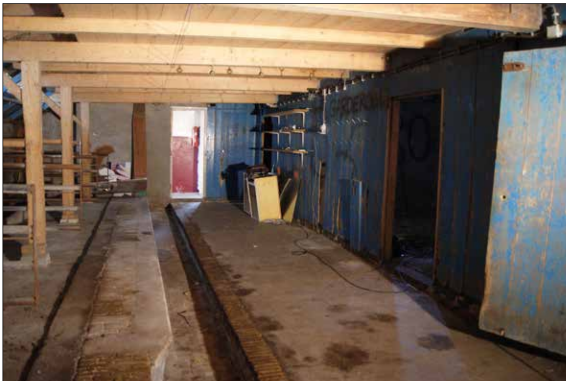
Afb. 37. Het looppad in de koeienstal met de blauwe wand tussen de stal en hooiberg.
