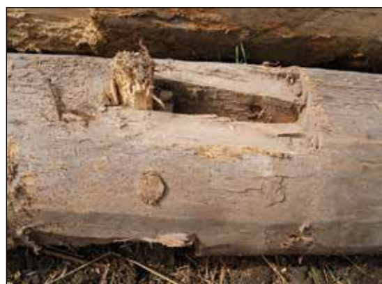
Afb. 61. Een van de stijlen met halverwege een pengat met toognagels voor de verbinding met de draagbalk.
