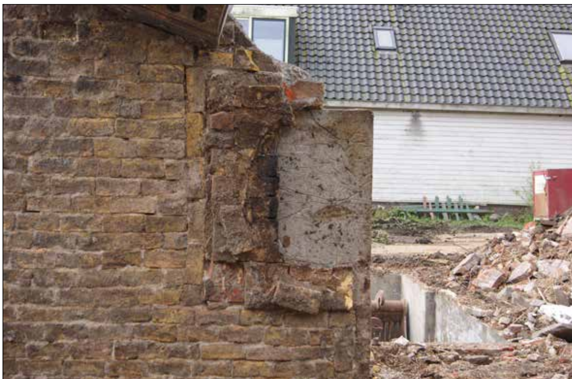
Afb. 36. Onder de betonvloer in de stal bleek bij de sloop een laag gele bakstenen aanwezig te zijn. In het midden de rand van de waterput. Foto genomen tijdens de sloop, terwijl de sloopkraan de vloer rechtop houdt.
