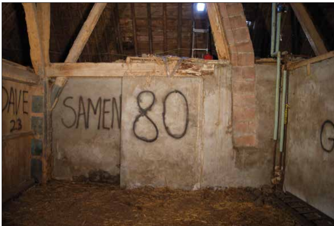
Afb. 42. De muur van het woongedeelte aan de zuidzijde, gezien vanuit de hooiberg. In het midden de onderzijde van het oude rookkanaal.
