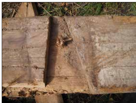
Afb. 56. Onderzijde van de oostelijke bovenbalk met een loef.
