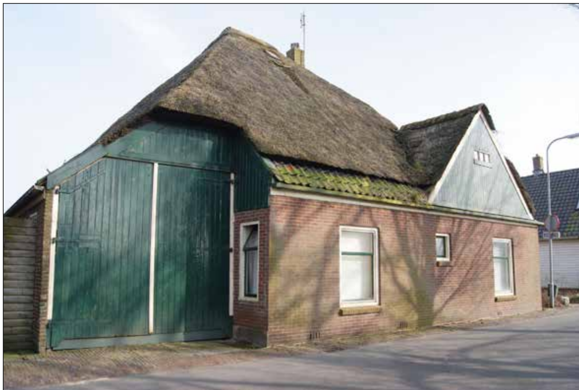
Afb. 24. Voorgevel van de boerderij in 2016, met links de darsdeuren.
