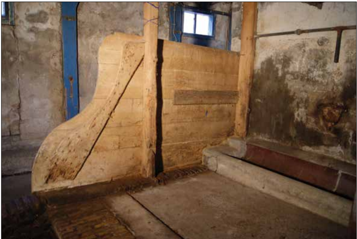
Afb. 35. Noordzijde van de koeienstal, met een houten schot tussen de koestand en het looppad naar de staart.
