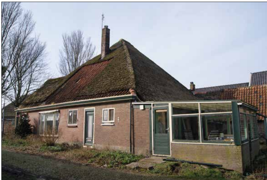
Afb. 28. De zuidelijke zijgevel in 2016.
