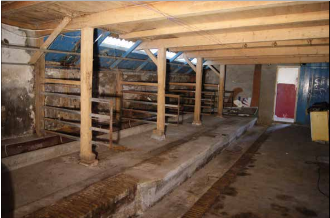
Afb. 34. De koeienstal aan de achterkant van de boerderij.
