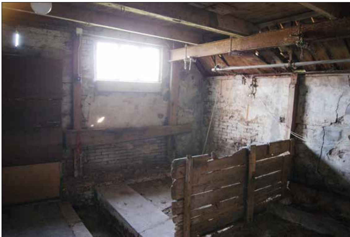
Afb. 41. De koeienstal in de staart.
