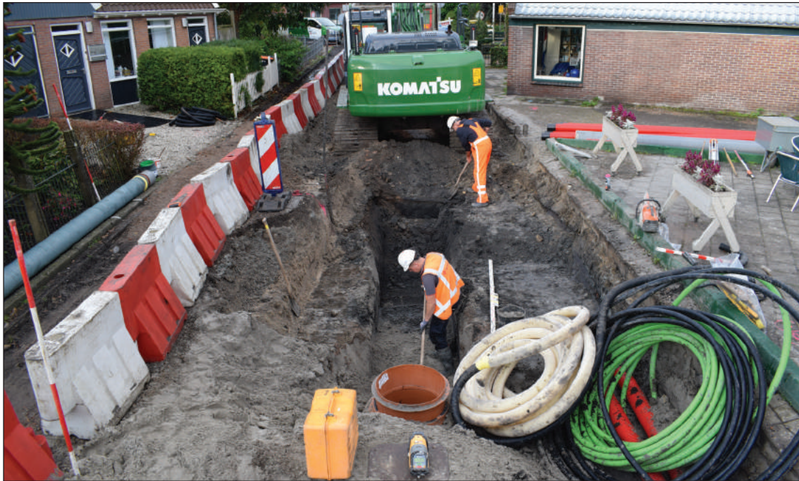
Afb. 44. Overzichtsfoto van de graafwerkzaamheden ter hoogte van Hemmerbuurt 76 met in het midden de riolsleuf.
