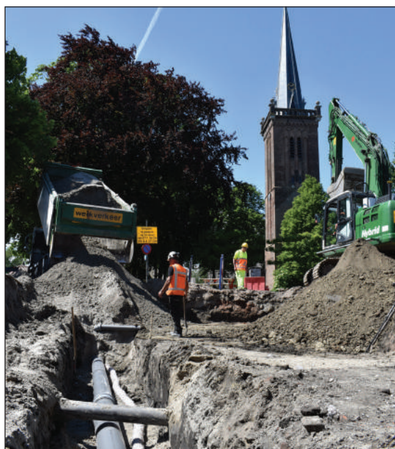
Afb. 45. De nieuwe rioolbuis is aangelegd ter hoogte van Hemmerbuurt 62, waarna de riolsleuf met schoon zand wordt dichtgestort.
