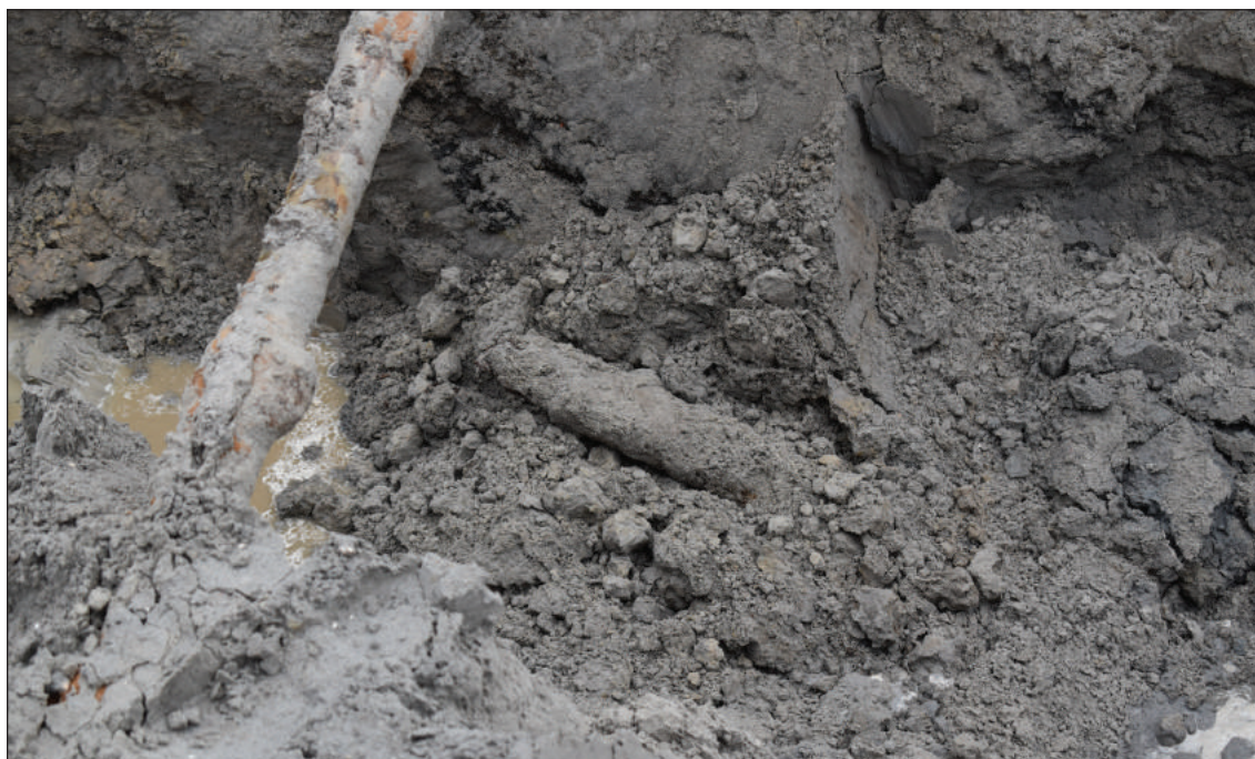
Afb. 78. Paal in de uitgegraven sleuf van Strukton Civiel West B.V nadat deze is losgetrokken door de kraan.
