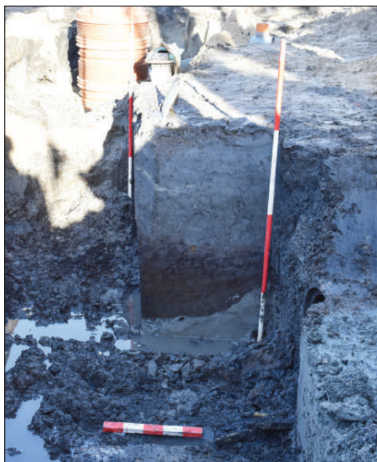
Afb. 57. Dwarsdoorsnede van de gedempte sloot (S10) ter hoogte van Hemmerbuurt 229. De foto is richting het oosten genomen. Op de voorgrond het muurtje van de brugfundering en rechts een deel van de duiker uit de jaren zestig van de 20ste eeuw.
