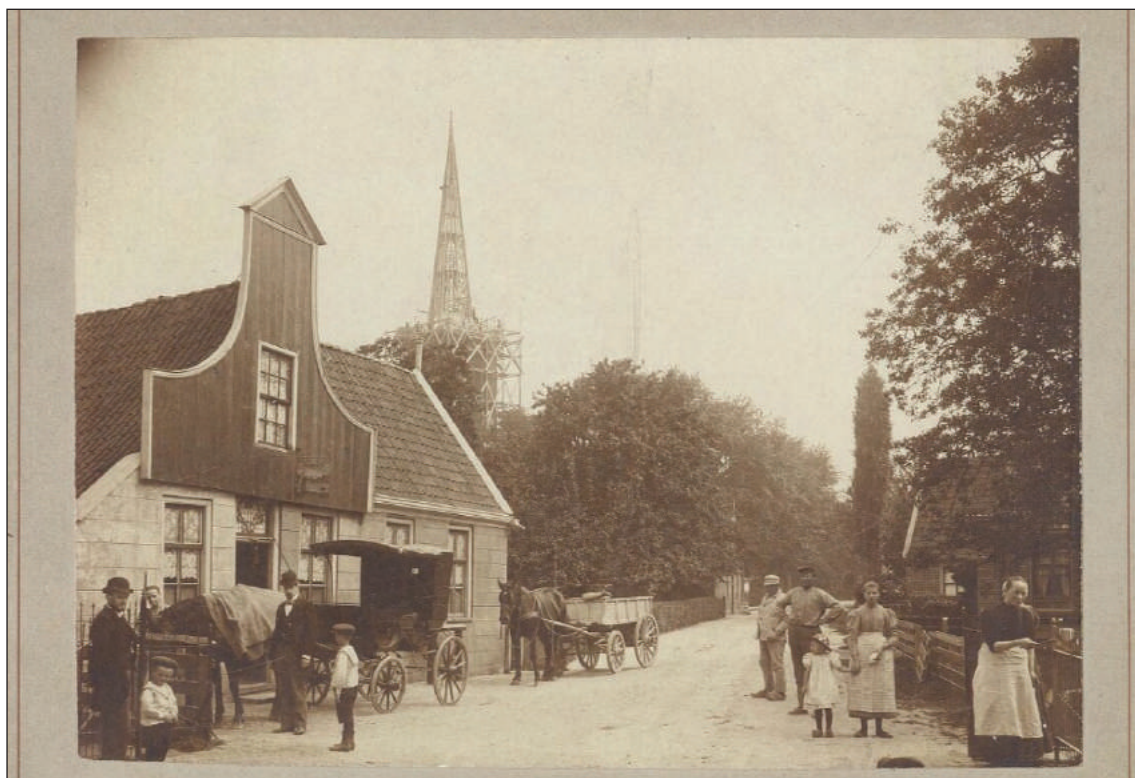
Afb. 28. Foto genomen in 1898 ter hoogte van Hemmerbuurt 119 met zicht op het oosten. Op de voorgrond het in 1928 afgebrande Café de Hoop en op de achtergrond de torenspits van de Hervormde kerk van Hem in herstel (West-Fries Archief inv. 18219).
