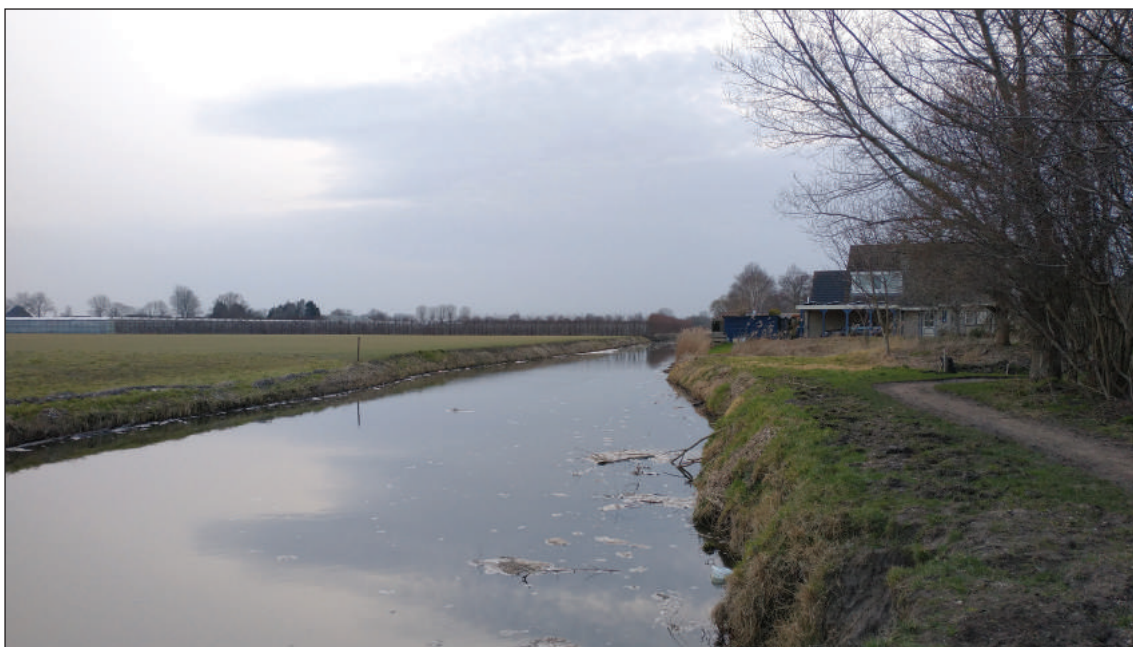
Afb. 5. De Hemmerbuurtkadijk, foto genomen ten zuidoosten van het Bomenland in Venhuizen met zicht op het zuidwesten.
