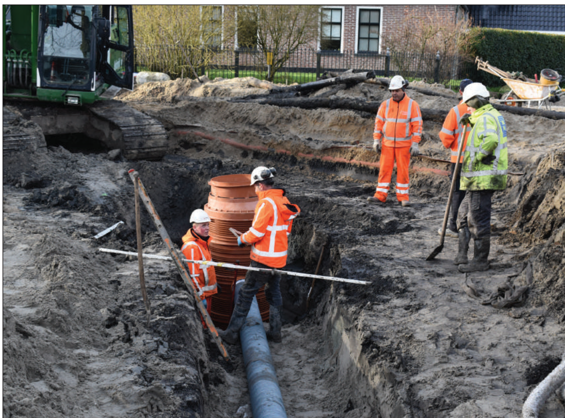
Afb. 46. Aanleg van een hemelwaterput op het kruispunt Hemmerbuurt-Meeweg.
