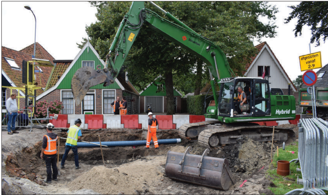
Afb. 2. Situatie ter hoogte van Hemmerbuurt 101 begin mei 2019, waar de graafwerkzaamheden van start gingen.
