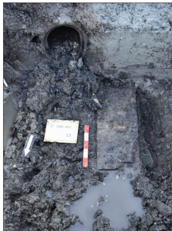
Afb. 59. De brugfundering (S11) in het midden van het kruispunt Hemmerbuurt-Meeweg met daarnaast de betonnen duiker uit de jaren zestig van de 20 ste eeuw. De foto is richting het zuiden genomen.
