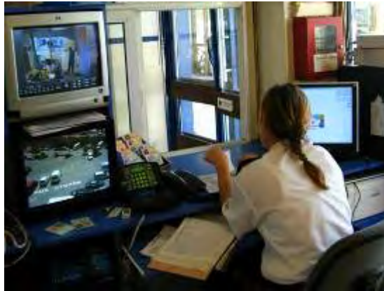
Yapılarda Kamera Uygulaması
