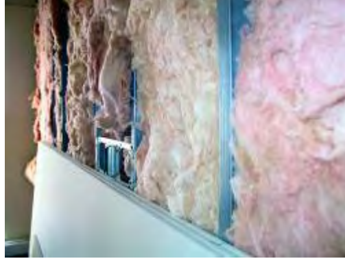
Isıya Dayanıklı Malzeme ile Duvar Kaplama
