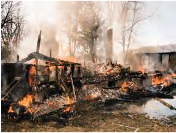
Ahşap Bina Yangını
