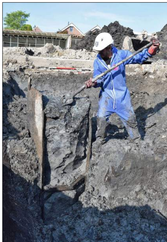
Afb. 53. De bovenzijde van de put wordt uitgegraven.
