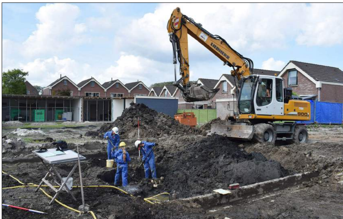
Afb. 16. De opgraving in volle gang.
