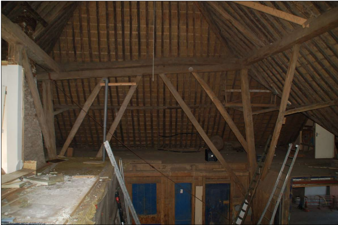
Afb. 37 De vierkantconstructie aan de achterkant (noordzijde) van de boerderij. Geheel links de schoorsteen.
