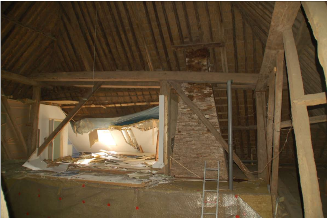
Afb. 38 De vierkantconstructie aan de linkerkant (westzijde) van de boerderij, met de schoorsteen.
