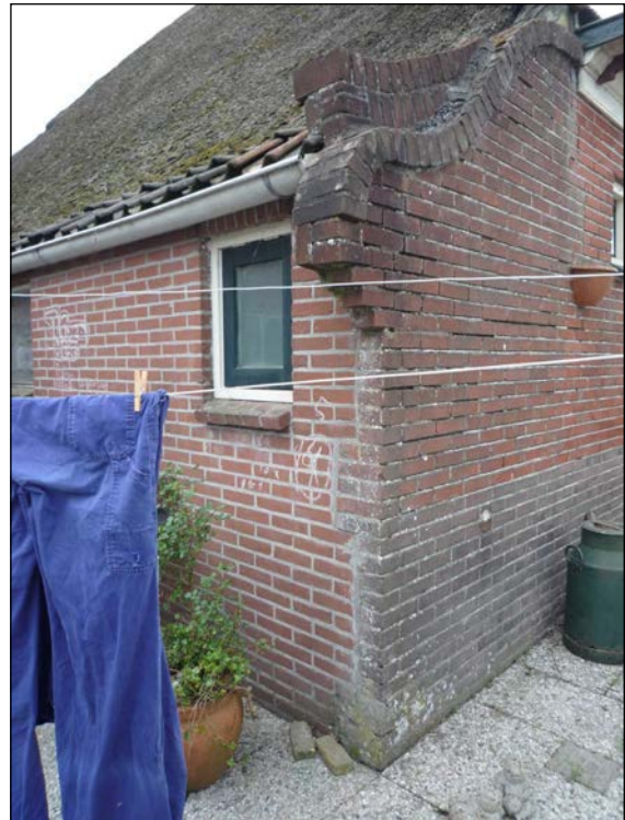
Afb. 26 Aangeloeft deel op de noordwesthoek van de boerderij met siermetselwerk.
