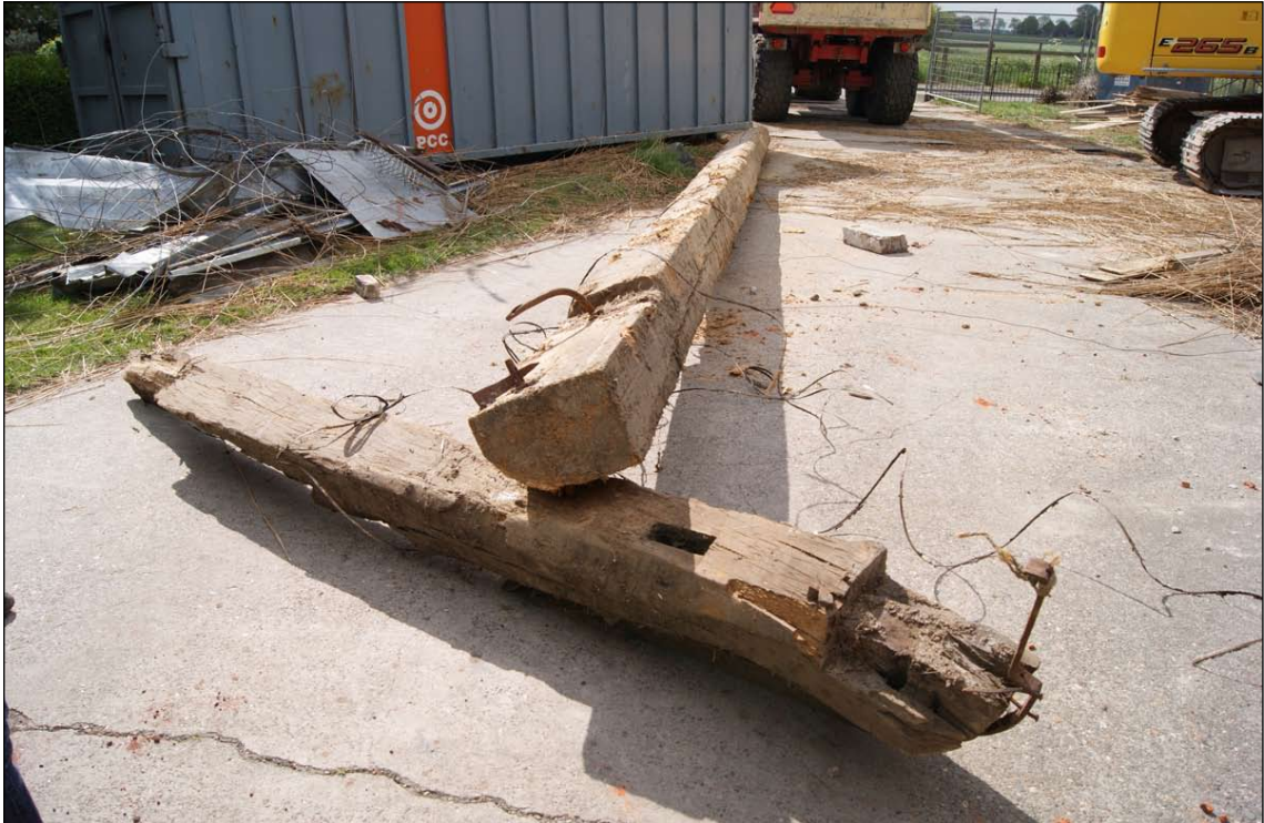
Afb. 44 Een deel van de eiken overstekbalk van de noordzijde (voorgond) met de grenen bovenste vierkantdekbalk van de westzijde.
