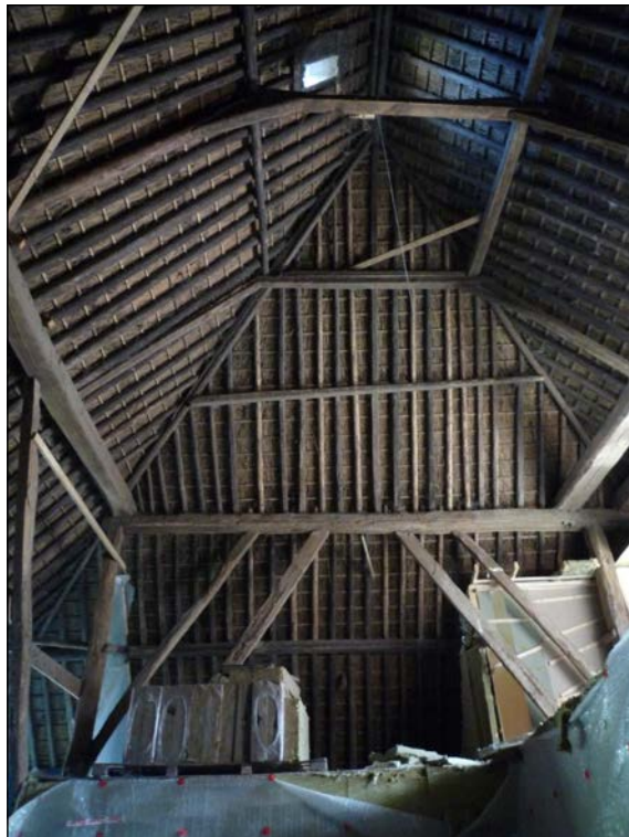
Afb. 31 De kapconstructie gezien richting het zuiden (voorgevel).
