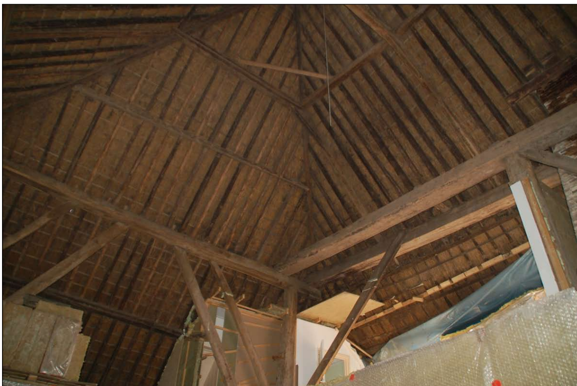
Afb. 32 De kapconstructie in de zuidwesthoek van de boerderij.
