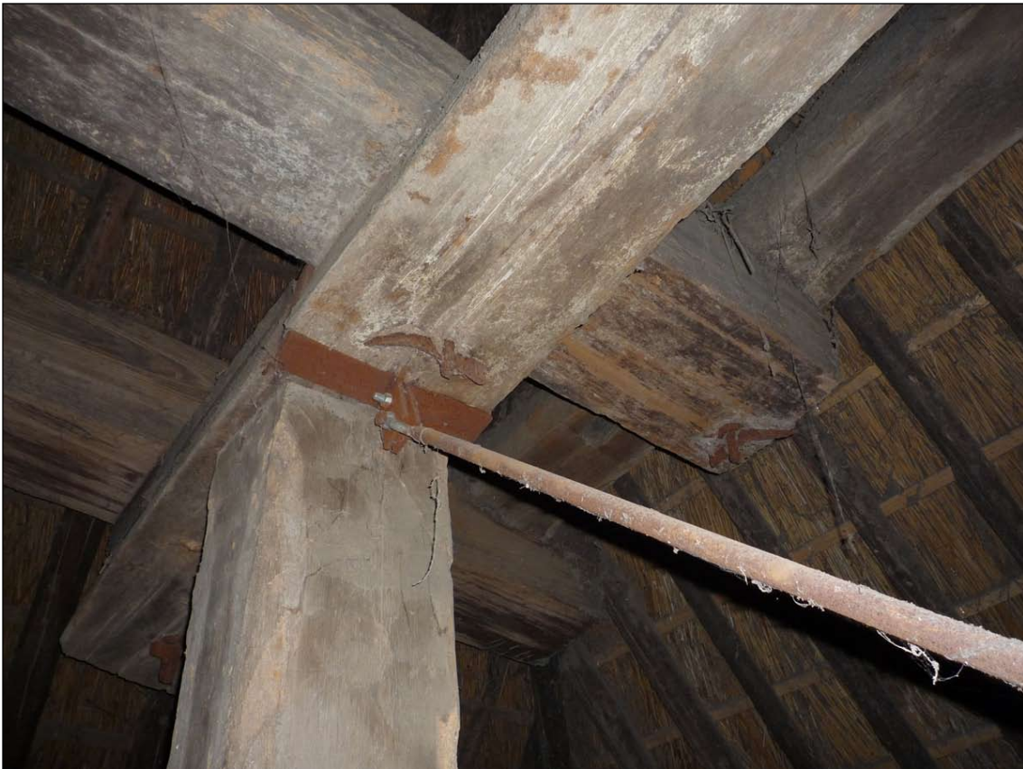
Afb. 43 Detail van de noordwesthoek van het vierkant, met vierkantstijl, vierkantdekbalk, bovenste vierkantdekbalk en overstekbalken.
