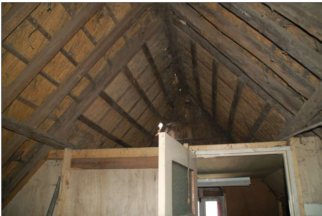
Afb. 46 De kapconstructie van de rechteraanbouw.
