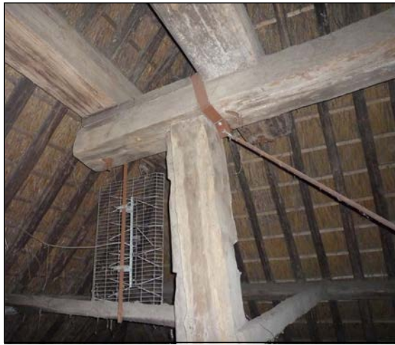
Afb. 42 De vierkantstijl in de noordwesthoek met eiken vierkantdekbalk (rechts) en grenen bovenste vierkantdekbalk en overstekbalk (links).
