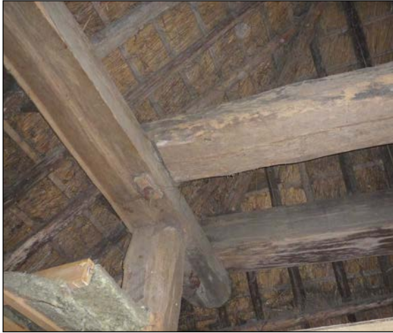
Afb. 41 De vierkantstijl in de zuidwesthoek met eiken vierkantdekbalk (links) en grenen bovenste vierkantdekbalk en overstekbalk (rechts).
