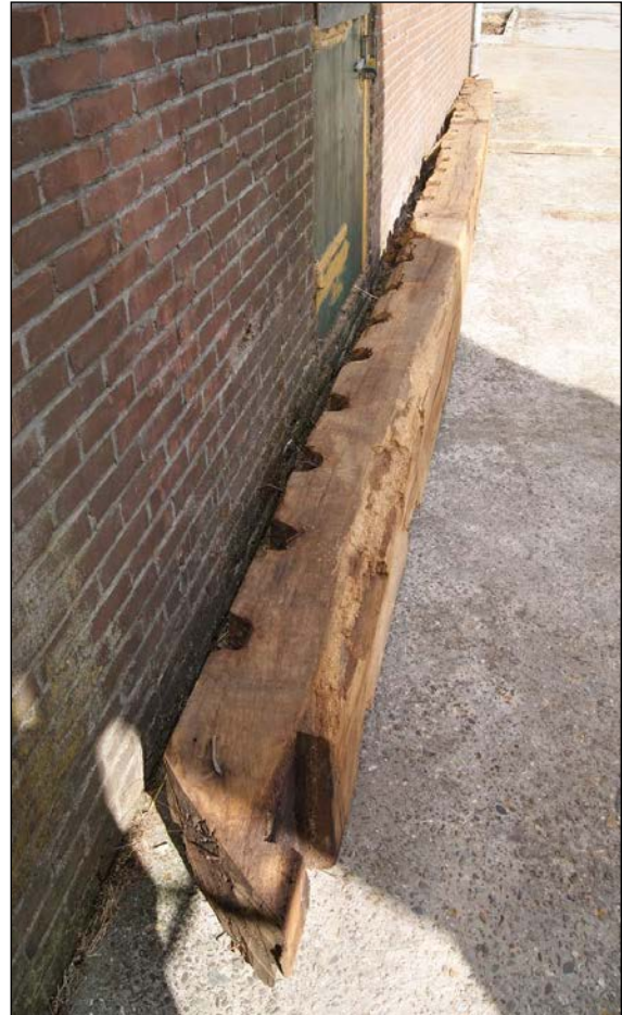
Afb. 35 Eiken bovenste vierkantbalk van de oostzijde na de sloop. Links inkepingen voor de sparren en rechtsvoor een inkeping op de locatie waar de balk op de vierkantbalk lag. Het uiteinde is schuin afgezaagd in de richting van het dakschild.
