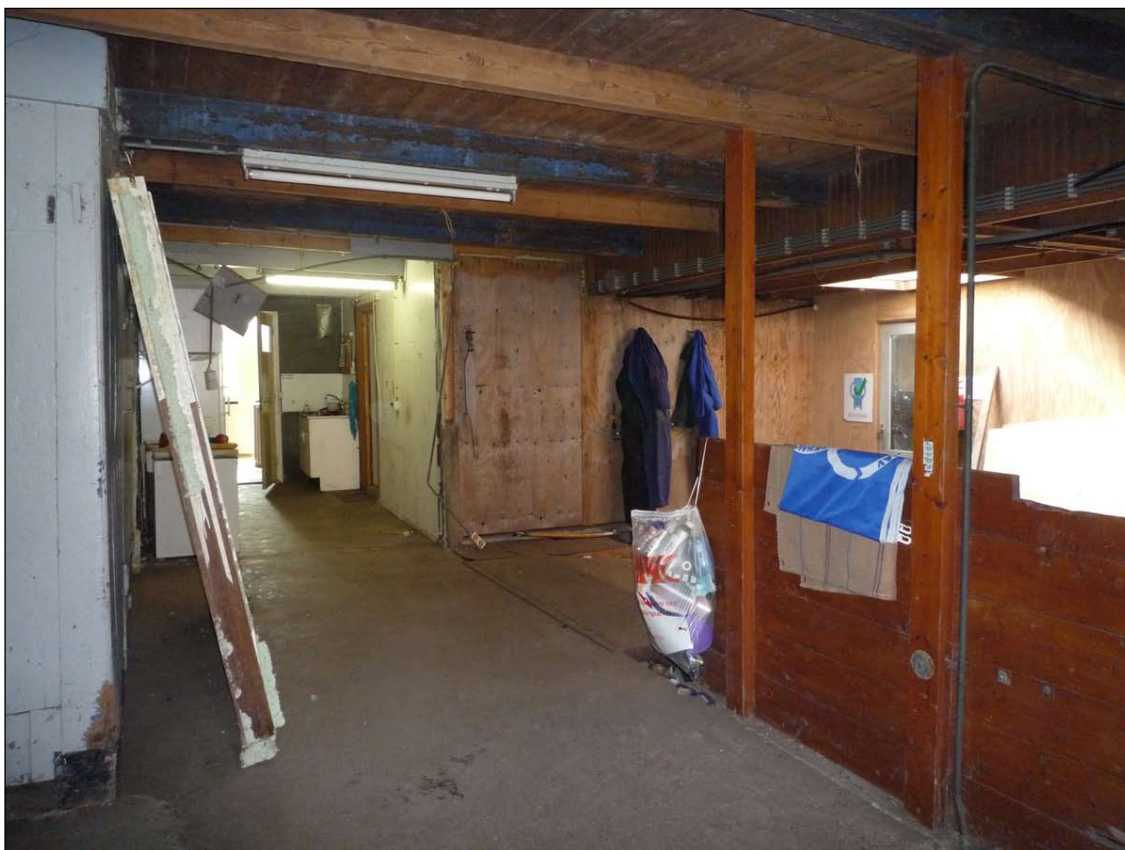
Afb. 45 Voormalige koegang met links de houten bedstedenwand en rechts de voormalige grup. In de balklaag zijn de originele blauw geschilderde balken nog aanwezig.
