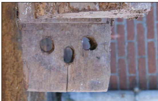
Afb. 34 Rechthoekige pen met drie gaten aan de bovenzijde van een van de vierkantstijlen.
