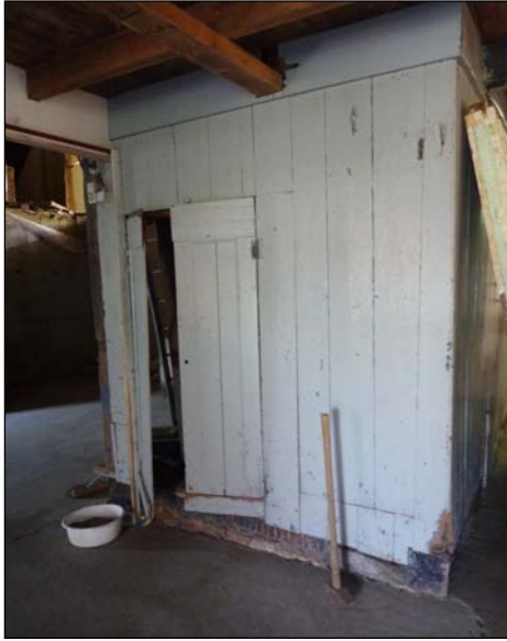
Afb. 28 Wand met deur van bedstede of kast in de voormalige koestal.
