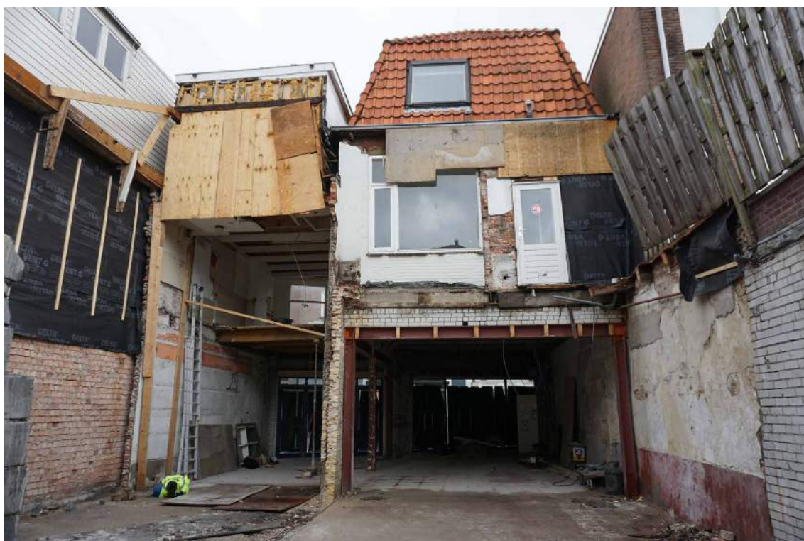
Afb. 10 De panden na afbraak van de aanbouwen en inpandig strippen.
