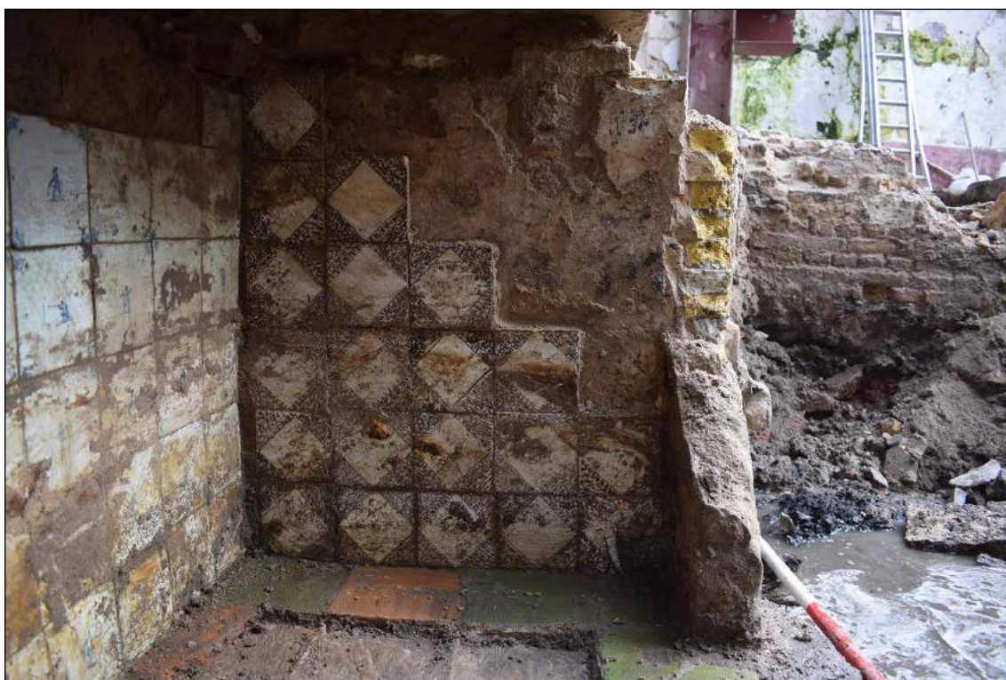
Afb. 19 De oostwand en de noordwand van de kelder.
